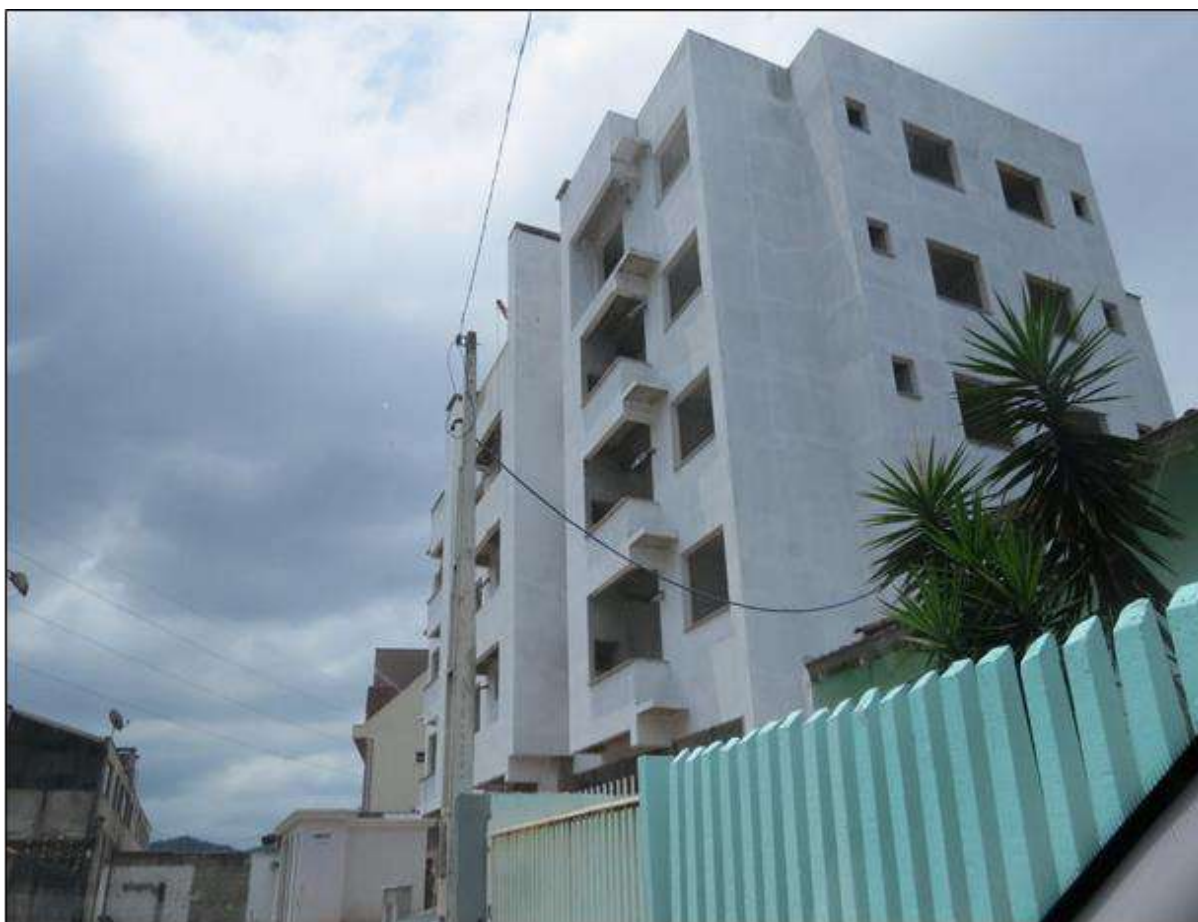
Figura 4. Vista diagonal do empreendimento em estudo. Autor: DBIO, 2019.
