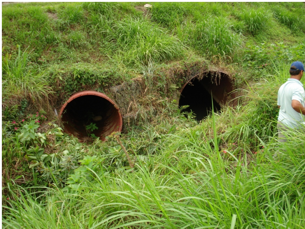
Foto 6.2 – Travessia da BR101 - Galeria Tubular Metálica Corrugada.
