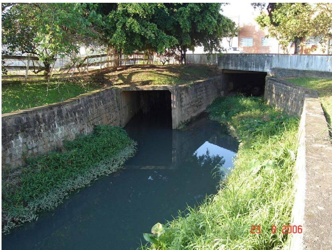
Foto 4.10 – Rio Morro Alto - Emboque a montante da rua Blumenau. Ao fundo construções sobre a galeria.
