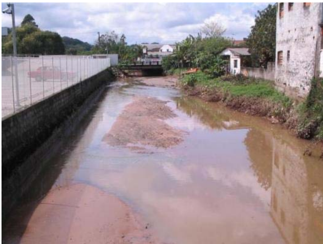
Foto 4.1 – Assoreamento no Rio Jaguarão – Rua Procópio Gomes.
