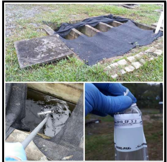
Saída ETE Profipo
