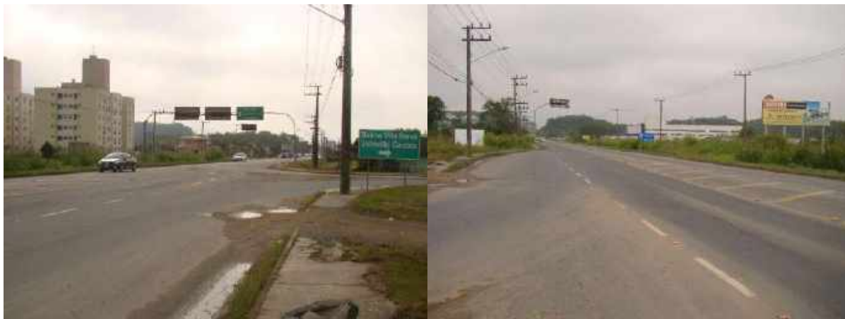
Figura 21. Uso do solo das áreas do entorno do empreendimento – face com a Rodovia Rodolfo Jahn – SC 108.
