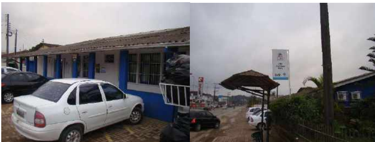
Figura 42. UBS Vila Nova, próximo ao imóvel.
