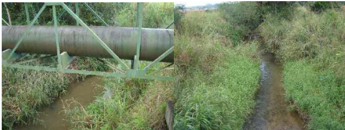
Figura 11. Rio Mutucas – montante e jusante a Rua São Firmino respectivamente.
