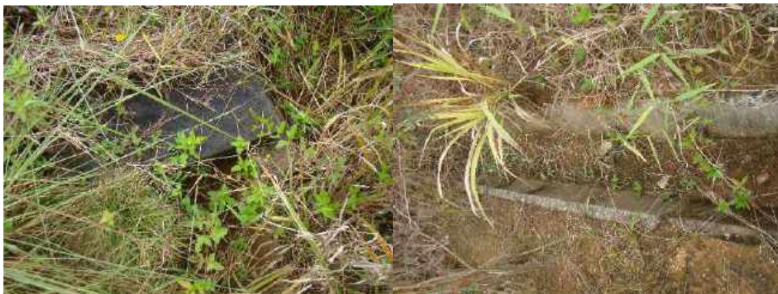
Figura 36. Drenagem superficial do terreno da ETE Vila Nova.
