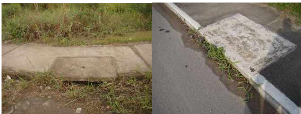
Figura 35. Bocas de lobo no Loteamento onde a ETE Vila Nova será implantada.
