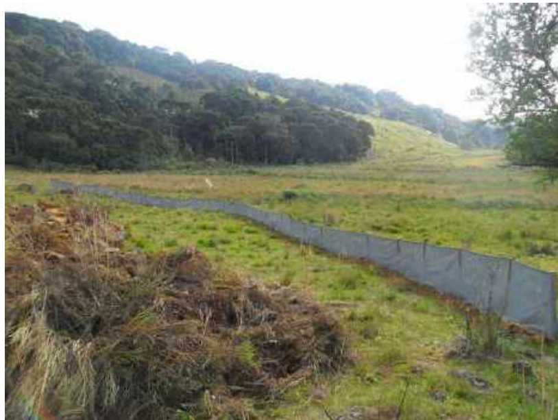
Figura 57. Exemplo dos dispositivos de proteção ambiental a serem adotados - barreiras de siltagem.
