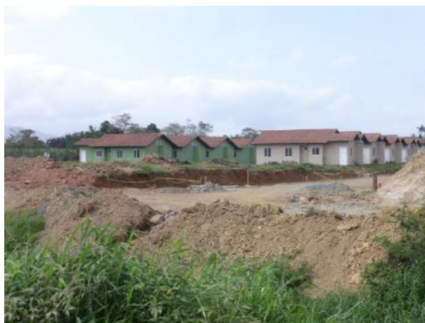
Foto 25 – Conjunto habitacional localizado a sudeste da ETE.
