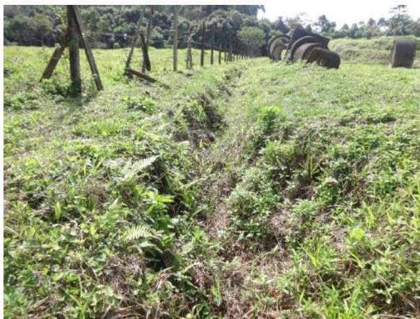
Foto 12 - Canal de escoamento seco na ETE Jardim Paraíso, devido baixa pluviosidade na região.
