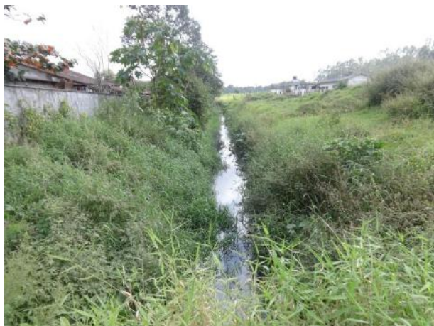
Foto 10 – Vala na lateral oeste da ETE Jardim Paraíso.
