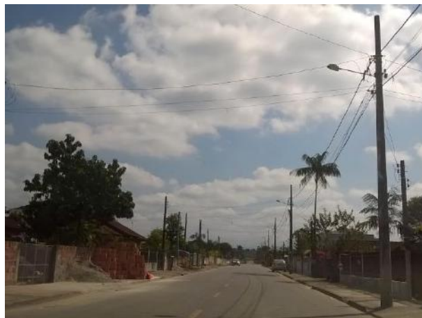
Foto 24 – Rua com pavimentação asfáltica.
