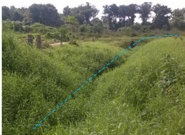
Foto 11 – Vala na AID do empreendimento.
