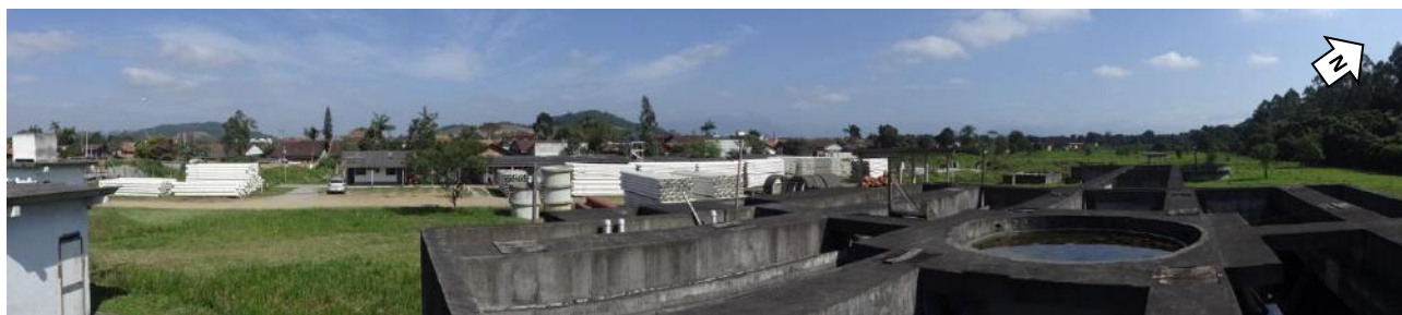
Foto 27 – Vista geral da ETE e de seu entorno, que apresenta vegetação arbórea, pasto e residências.
