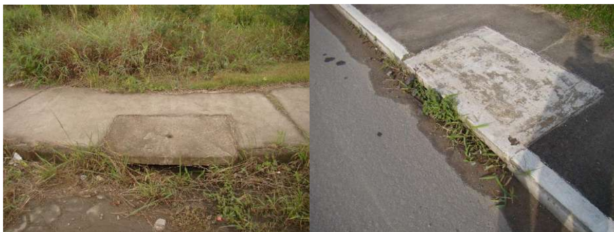
Figura 51. Bocas de lobo no Loteamento onde a ETE Vila Nova será implantada.
