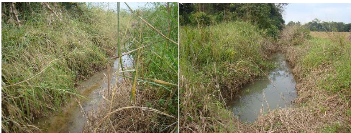
Figura 55. Macro drenagem entre a SC-108 e terreno da ETE Vila Nova.
