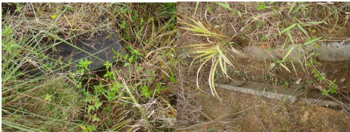
Figura 52. Drenagem superficial do terreno da ETE Vila Nova.
