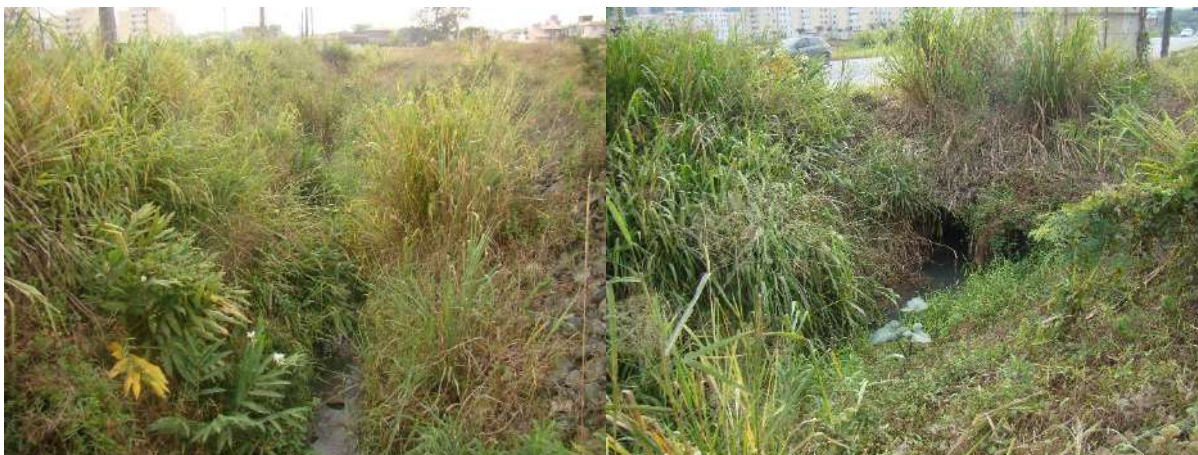
Figura 54. Macro drenagem entre a SC-108 e terreno da ETE Vila Nova.
