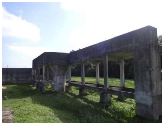
Foto 7 – Sombra projetada às 10h50min, em estrutura da ETE Jardim Paraíso.
