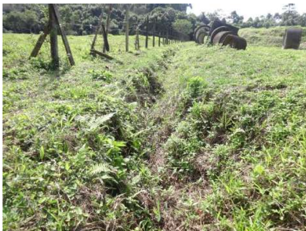
Foto 12 - Canal de escoamento seco na ETE Jardim Paraíso, devido baixa pluviosidade na região.
