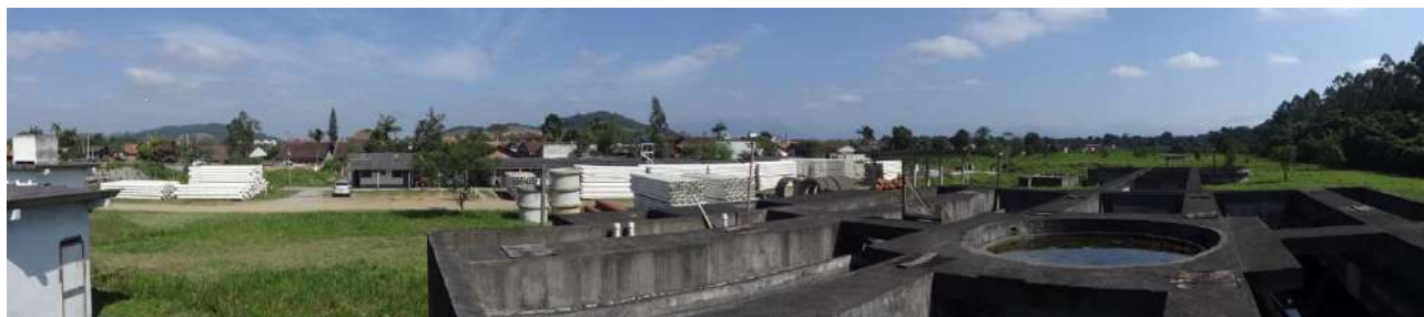
Foto 1 – Vista geral da ETE Jardim Paraíso.
