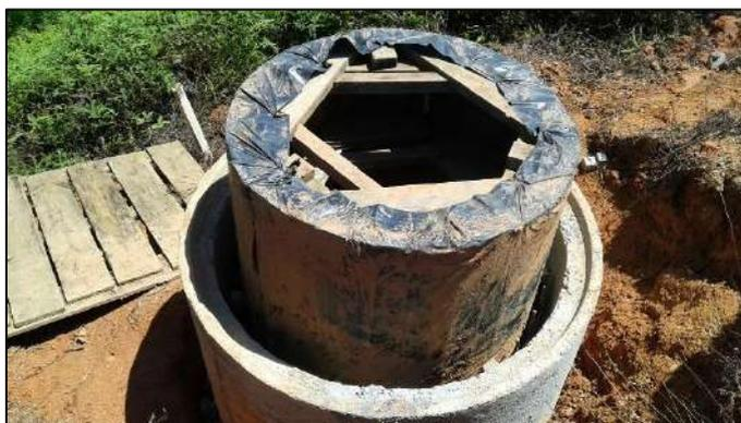
Figura 3 - Tamponamento e Cercamento
