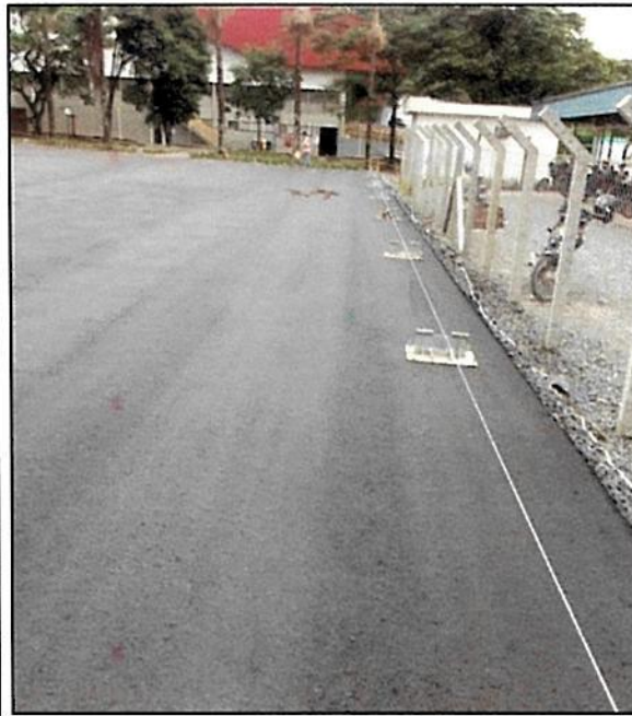
Figura 3 - Início da montagem do galpão lonado, Data: 17.02.2016.
