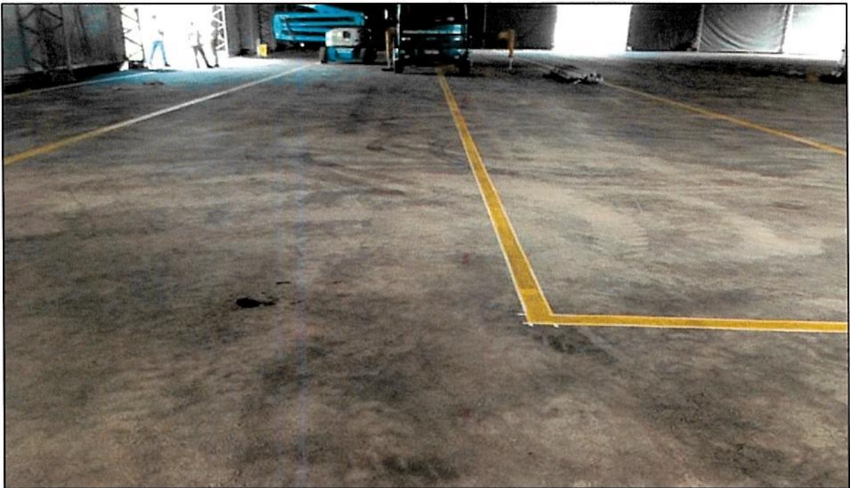
Figura 8 – Início da limpeza interna e realização de pintura/demarcação Data: 01.03.2016
