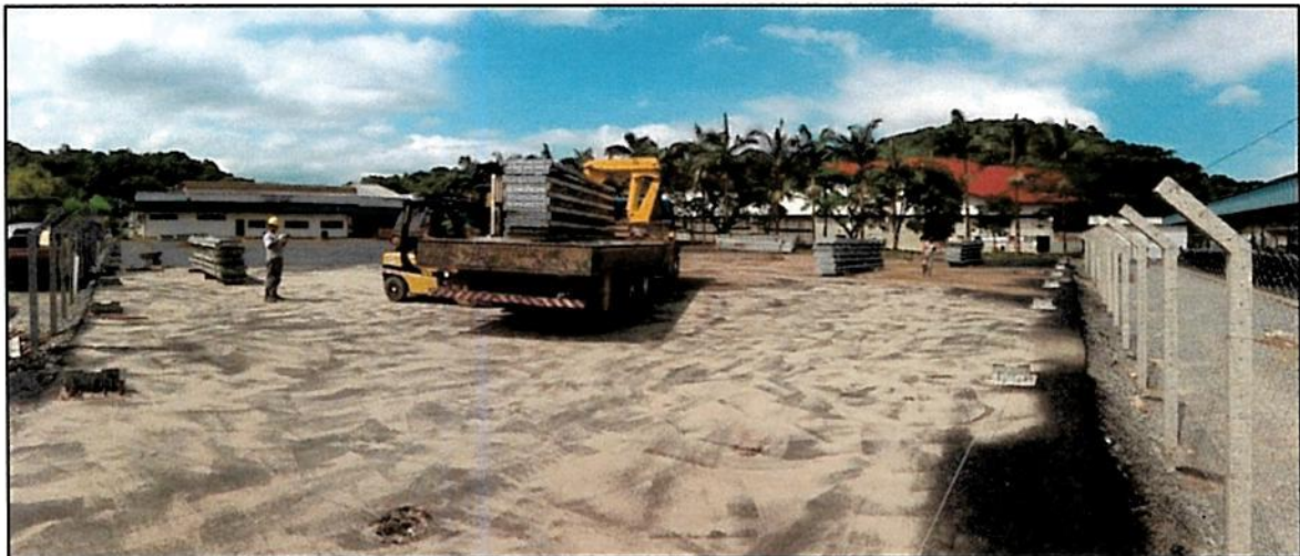
Figura 4 - Finalização da montagem das bases e transferência das estruturas - Data 17.02.2016
