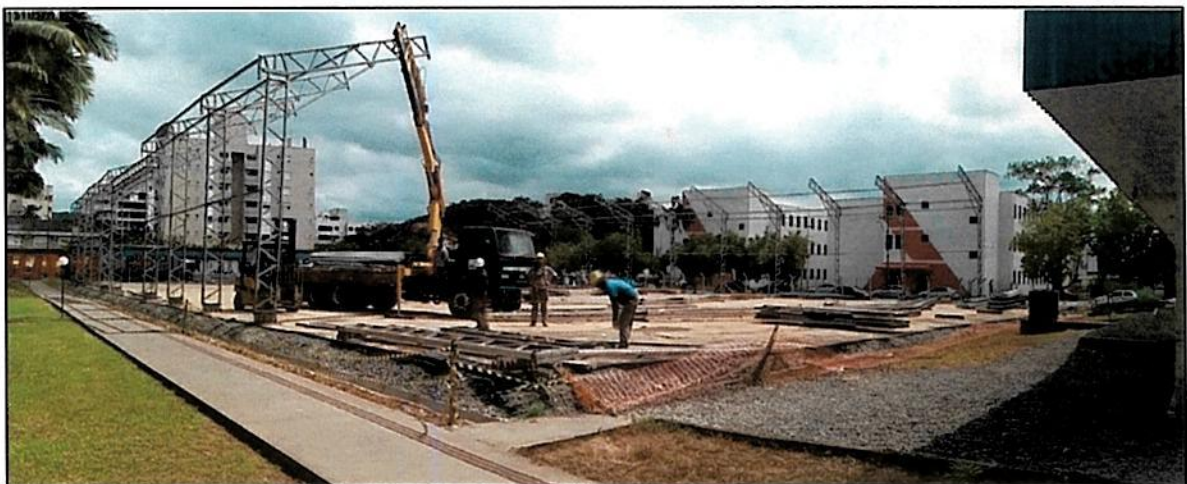
Figura 6 - Içamento dos pilares e travamento dos pilares – Data 19.02.2016
