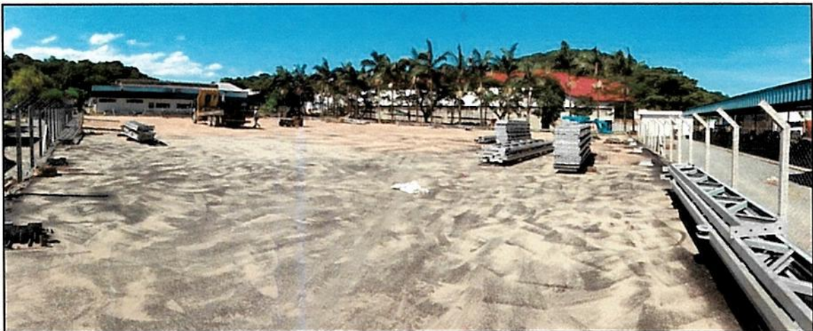
Figura 5 - Montagem dos pilares e montagem terças de fechamento – Data 18.02.2016
