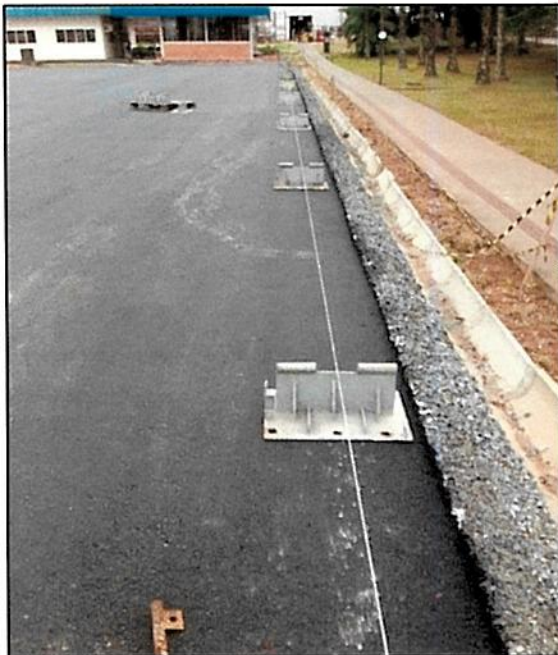
Figura 2 - Início da montagem do galpão lonado, Data: 17.02.2016.
