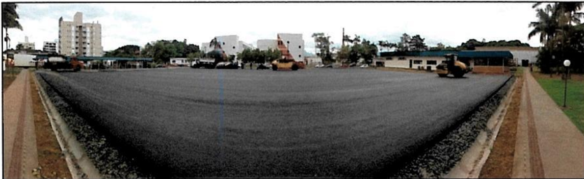
Figura 1 - Colocação da pavimentação asfáltica, Data:15.02.2016.
