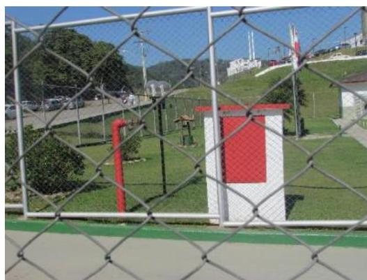
Foto 4-17 - Sistema hidráulico preventivo e hidrante para combate a incêndio
