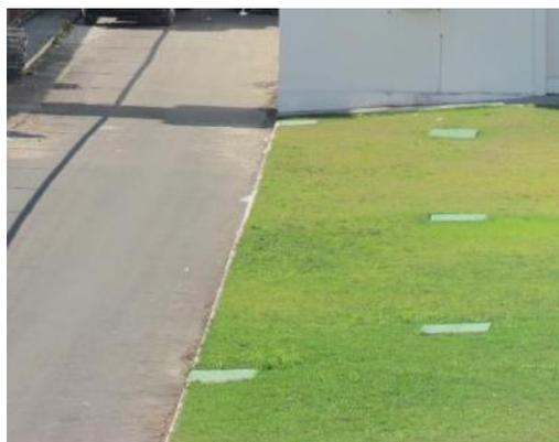
Foto 4-15 - Bocas de lobo, compondo o sistema de drenagem pluvial do empreendimento
