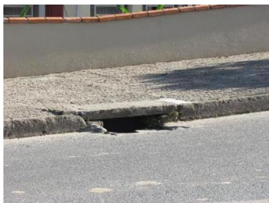
Foto 8-39 - Boca de lobo para coleta das águas pluviais
