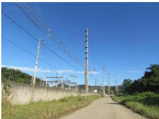
Foto 8-37 - Linhas de alta tensão elétrica, de distribuição e iluminação pública
