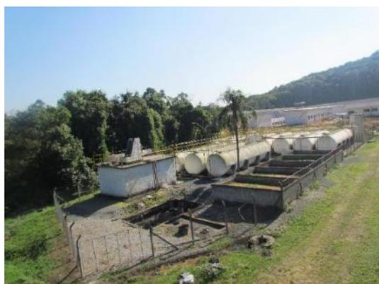
Foto 4-12 - Estação de Tratamento de Esgotos do complexo
