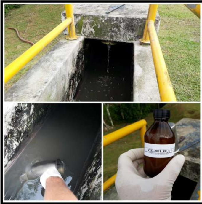
Entrada ETE Profipo
