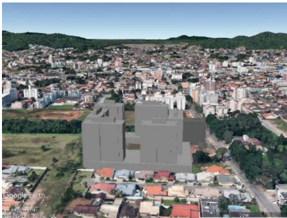
Figura 111. Vista ao leste do futuro Condomínio.
