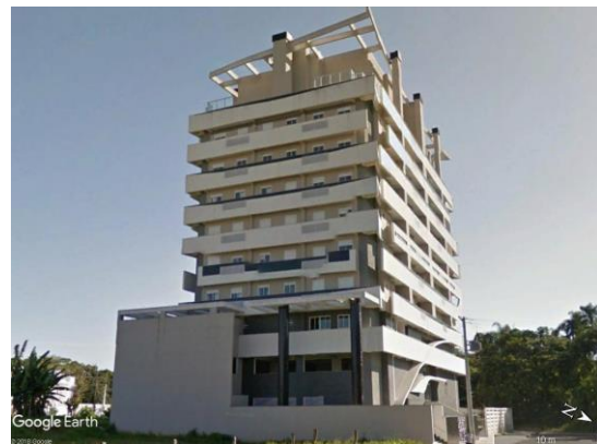
Figura 105. Residencial Saint Peter, na Rua Marcílio Dias.
