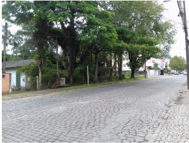
Figura 92. Trecho da Rua Presidente Prudente de Moraes, com pavimentação de paralelepípedo.
