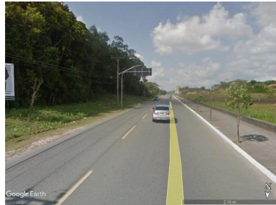
Figura 94. Trecho da Rua Marquês de Olinda, com pavimentação asfáltica.
