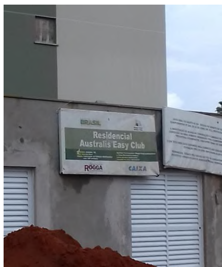
Figura 108. Construção do Residencial Australis Easy Club, na Rua Almirante Jaceguay.
