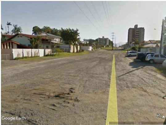
Figura 93. Trecho da Rua Almirante Jaceguay, sem pavimentação.
