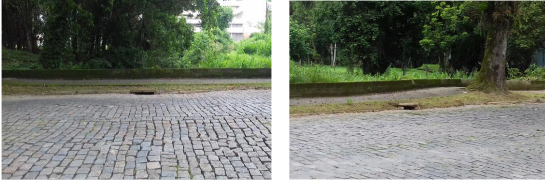
Figura 100. Caixas de saída da água pluvial.
