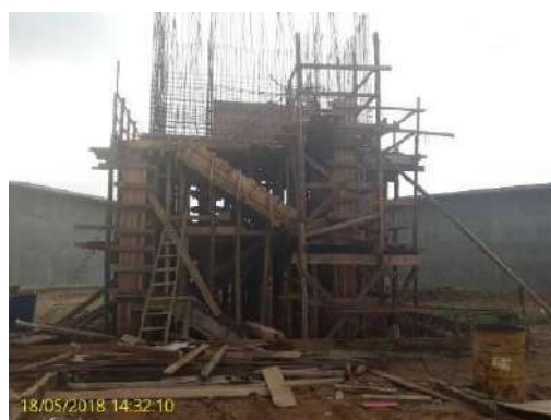
Foto 12 – Fiscalização – Obras em andamento – ETE Jarivatuba (mai/2018)
