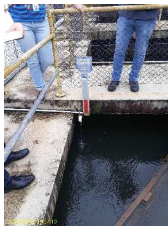
Foto 2 – Fiscalização - Decantadores da ETA Cubatão
