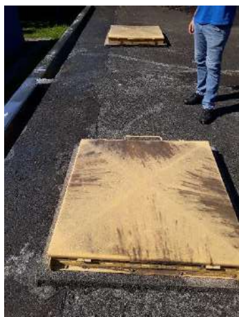
Foto 3 – Fiscalização – Reservatório R2
