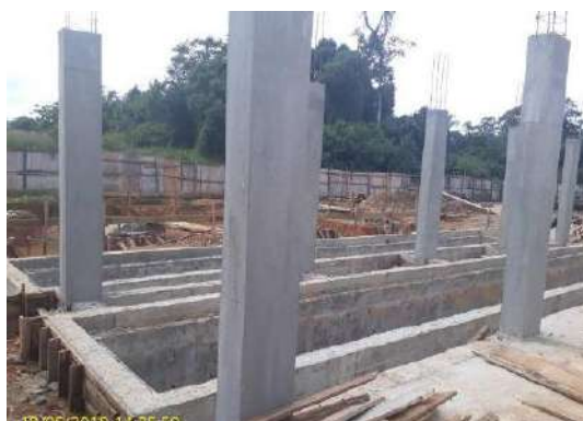
Foto 11 – Fiscalização – Obras em andamento – ETE Jarivatuba (mai/2018)
