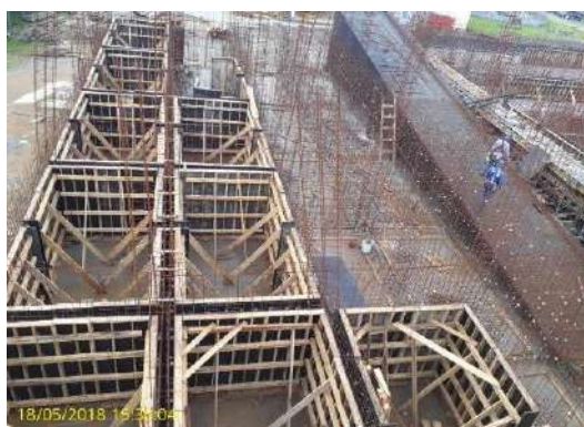
Foto 14 – Fiscalização – Obras em andamento – ETA Cubatão (mai/2018)
