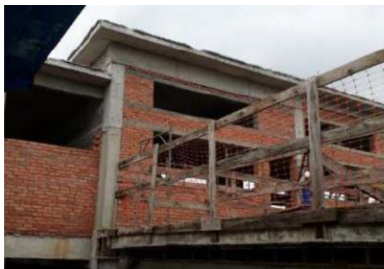
Foto 10 – Visita Técnica – Obra em andamento – ETA Cubatão (nov/2017)
