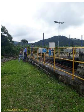
Foto 1 – Fiscalização - Captação da ETA Cubatão
