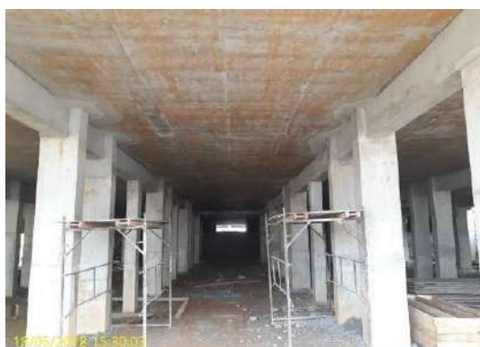
Foto 13 – Fiscalização – Obras em andamento – ETA Cubatão (mai/2018)
