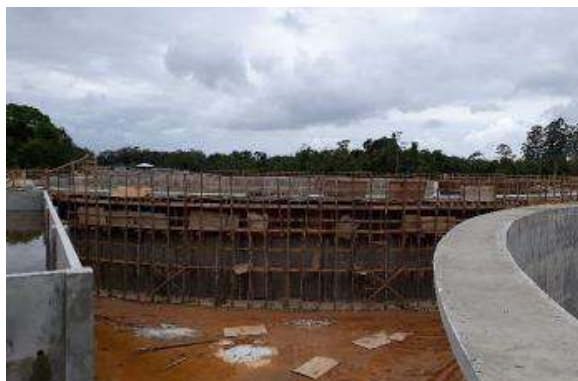
Foto 9 – Visita Técnica – Obra em andamento – ETE Jarivatuba (nov/2017)
