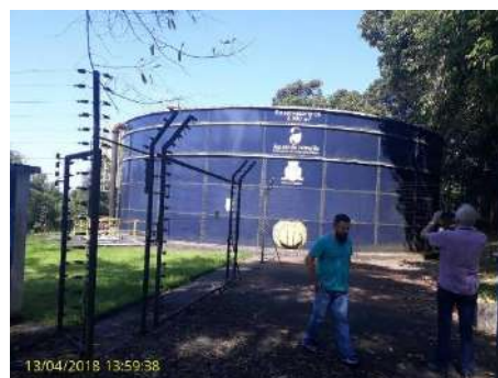
Foto 4 – Fiscalização - Reservatório R5
