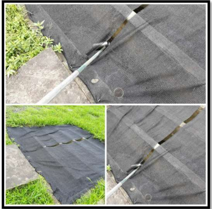
Saída ETE Profipo
