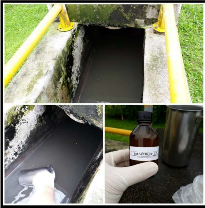
Entrada ETE Profipo
