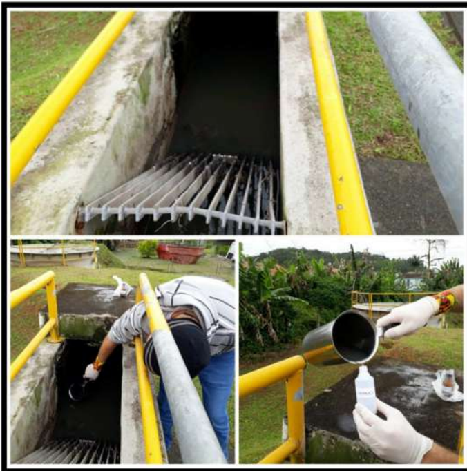
Entrada ETE Profipo
