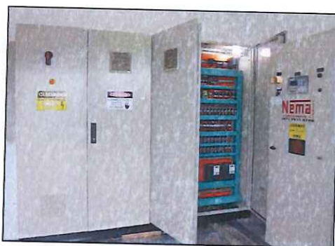
Figura 23: Entrada, com o quadro de transferência para uso de gerador.
