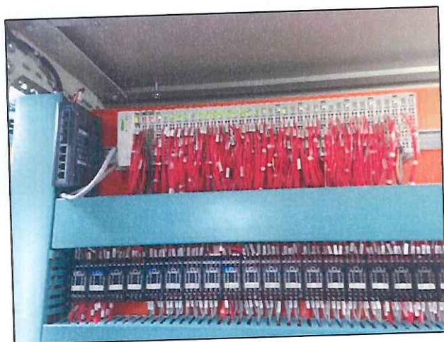
Figura 25: Sistema gerenciado por CLP (as informações podem ser visualizadas tanto no supervisor da ETE espinheiros, como na central da CAJ).
