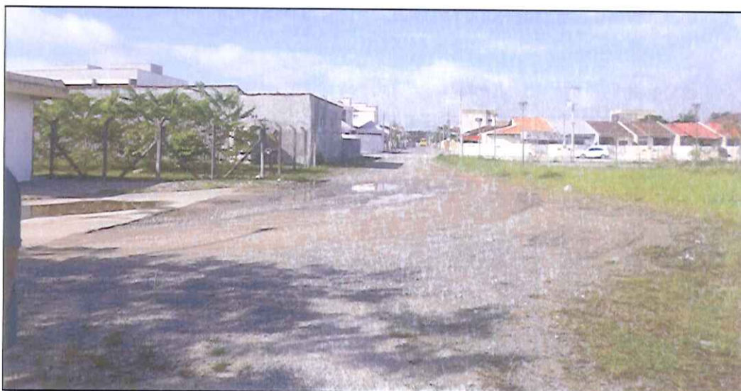
Figura 8: Rua não pavimentada – trecho final da Rua Francisco Rodrigues Miranda (entrada da ETE Espinheiros).
