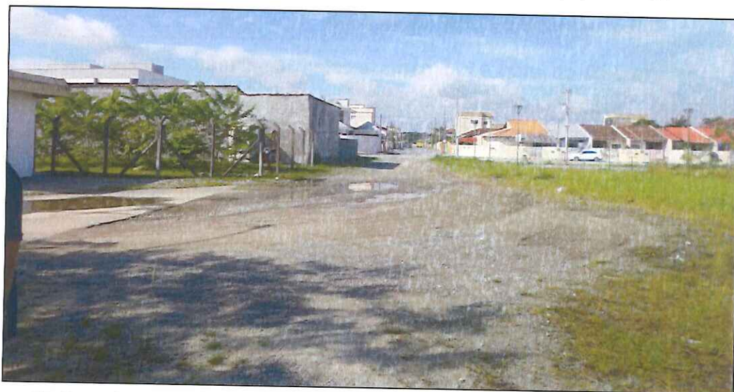
Figura 78: Rua não pavimentada – trecho final da Rua Francisco Rodrigues Miranda (entrada da ETE Espinheiros).
