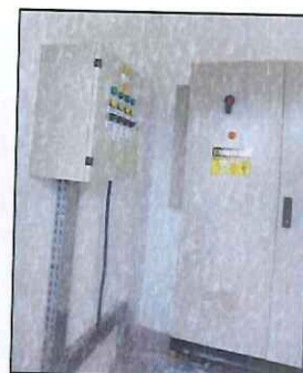
Figura 23: Entrada, com o quadro de transferência para uso de gerador.
