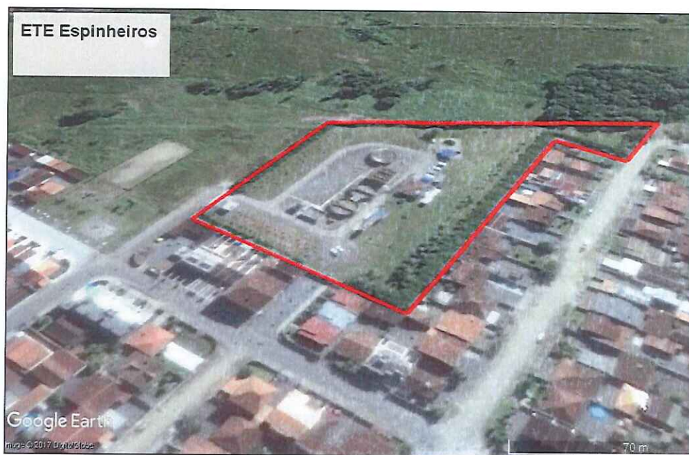
Figura 54: Ocorrência de sombreamento da ETE Espinheiros.
