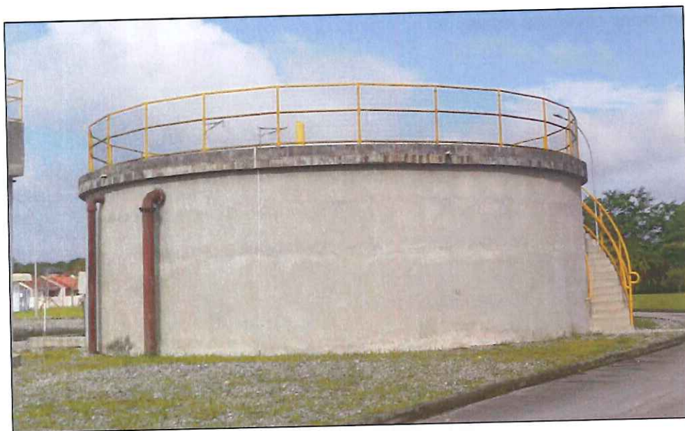
Figura 5: Equalizador ETE Espinheiros.
