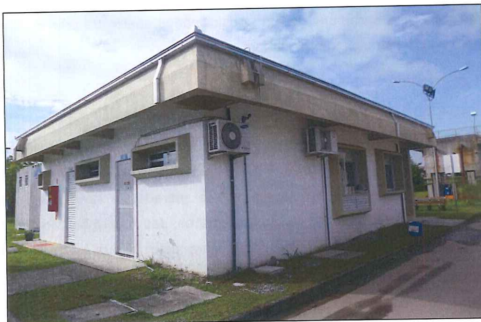
Figura 33: Unidade administrativa existente da ETE.
