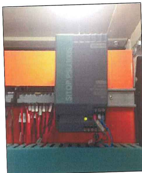
Figura 25: Sistema gerenciado por CLP (as informações podem ser visualizadas tanto no supervisor da ETE espinheiros, como na central da CAJ).
