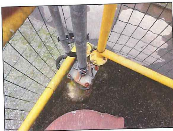
Figura 28: Sistema de Proteção de Descargas Atmosféricas.
