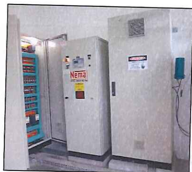
Figura 23: Entrada, com o quadro de transferência para uso de gerador.
