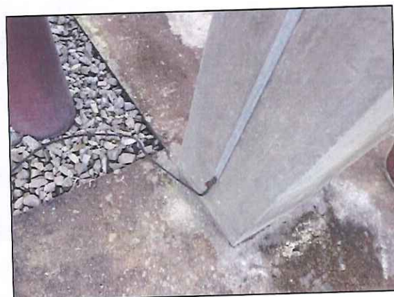
Figura 28: Sistema de Proteção de Descargas Atmosféricas.
