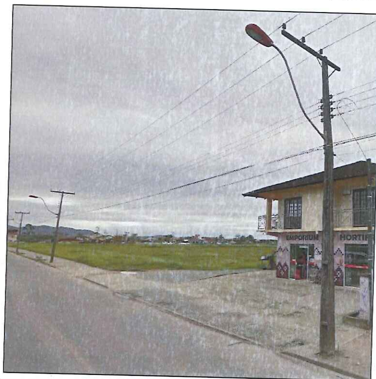
Figura 81: Iluminação pública na Rua Prefeito Baltazar Buschle.
