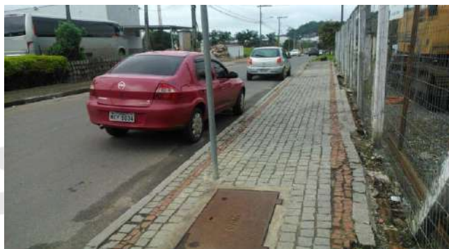
Figura 65. Caixa de passagem exemplificando uma das concessionárias de telefonia, internet e TV localizada na Rua Hermam Metz
