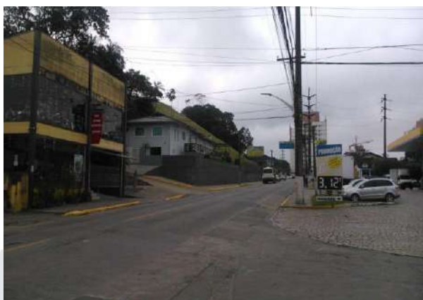
Figura 63. Estabelecimento comercial e posto de combustíveis com lavação de automóveis. Fonte: Neo Green Consultoria Ambiental
