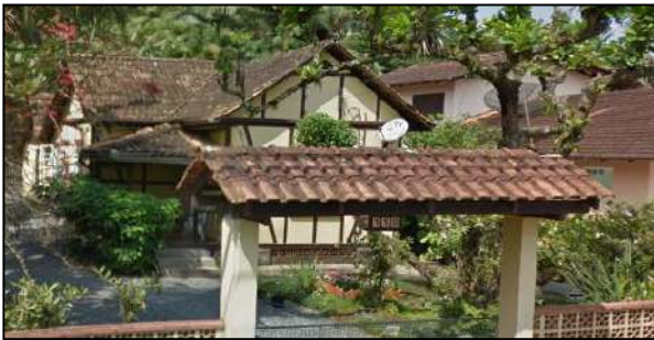
Figura 77. UIP 2 – Rua Bagé, nº 119 Fonte: Neo Green Consultoria Ambiental
