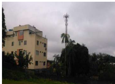
Figura 66. Vista parcial de torre de telefonia móvel na região de estudo.
