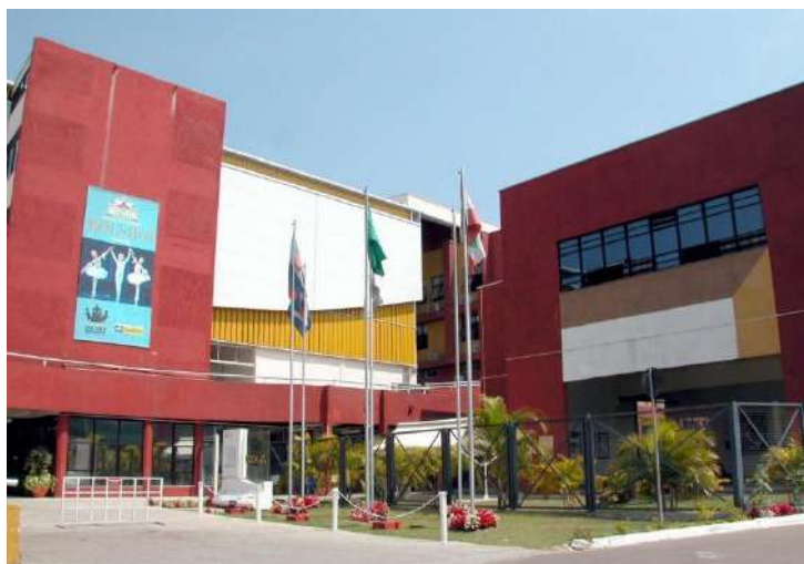
Figura 47. Teatro Bolshoi Joinville. Fonte - Neo Green Consultoria Ambiental Ltda.
