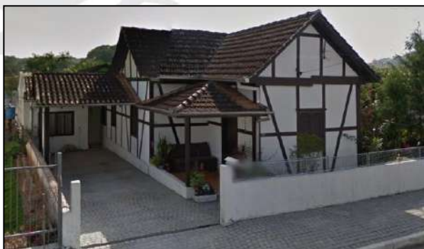
Figura 83. UIP 8 – Rua Palmares nº 135 Fonte: Neo Green Consultoria Ambiental
