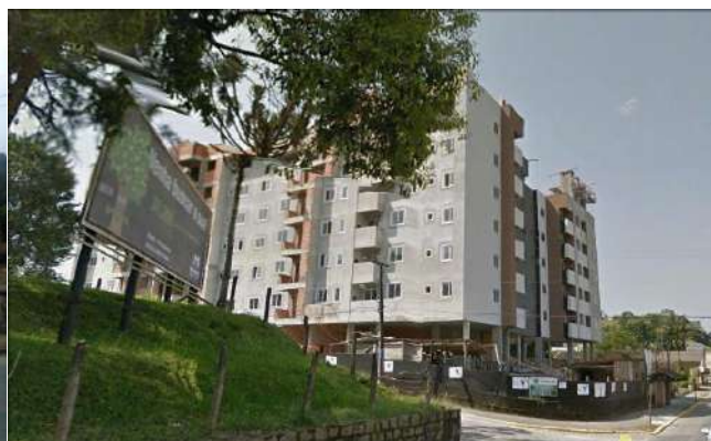
Figura 56. Condomínio de edifícios residenciais em fase final de construção Fonte: Neo Green Consultoria Ambiental
