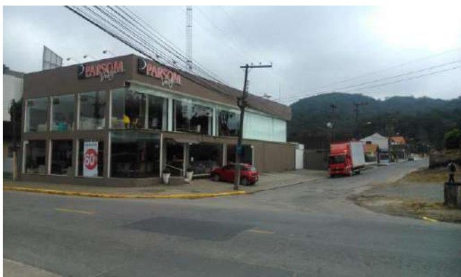
Figura 55. Estabelecimento comercial Fonte: Neo Green Consultoria Ambiental
