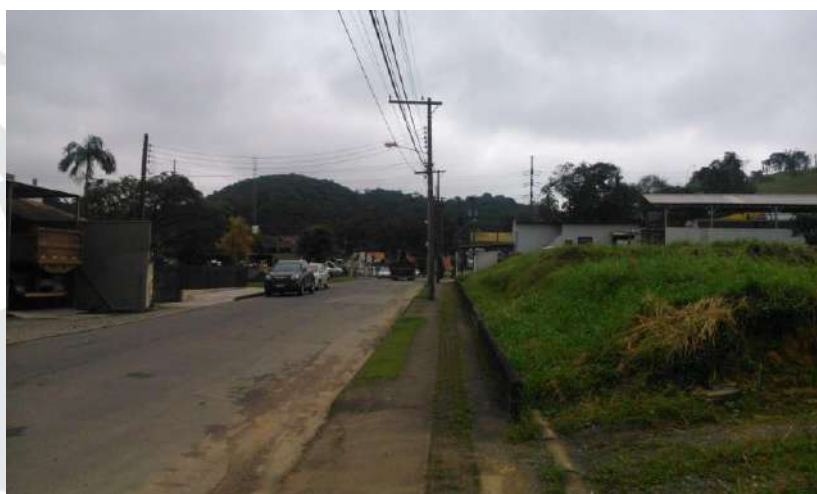
Figura 68. Vista parcial da Rua Hermam Metz com rede de iluminação pública instalada. Ao fundo, na congruência desta rua com a Rua Ottokar Doerffel nota-se redes de distribuição com geradores de energia elétrica Fonte: Neo Green Consultoria Ambiental
