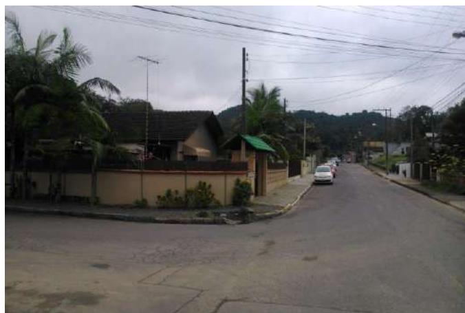
Figura 67. Via pavimentada em bom estado de conservação. Rua Hermam Metz Fonte: Neo Green Consultoria Ambiental
