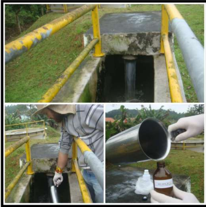
Entrada ETE Profipo
