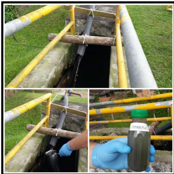
Entrada ETE Profipo
