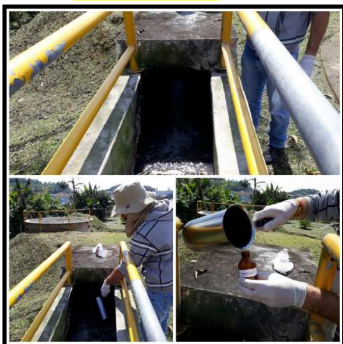
Entrada ETE Profipo
