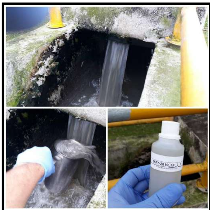
Entrada ETE Profipo
