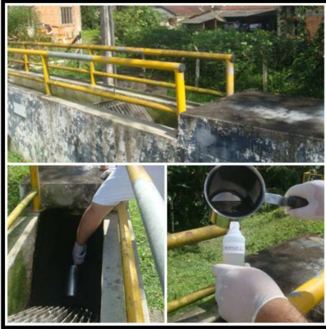
Entrada ETE Profipo
