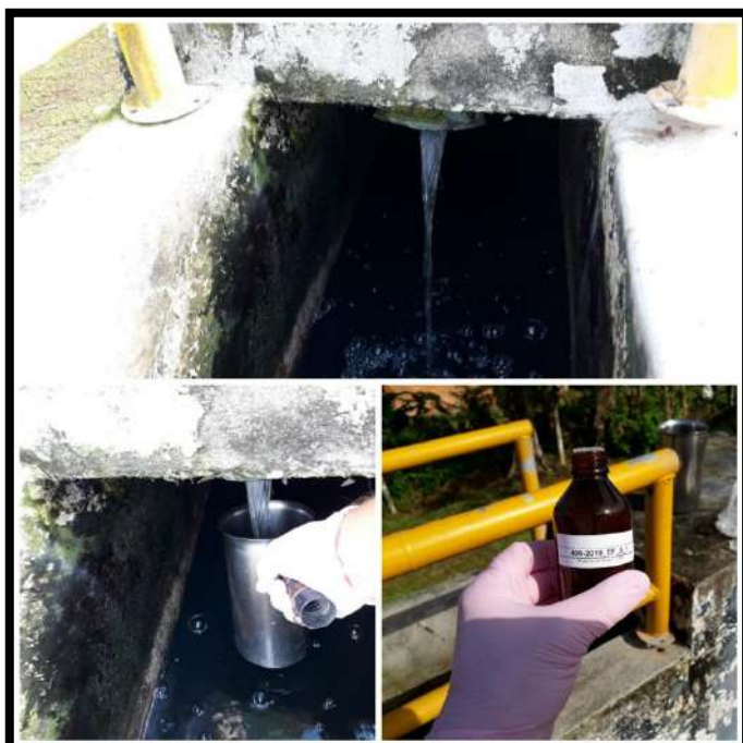
Entrada ETE Profipo
