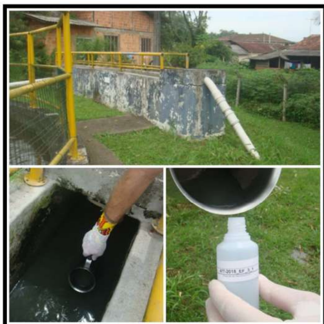
Entrada ETE Profipo
