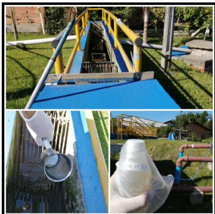
Entrada ETE Profipo
