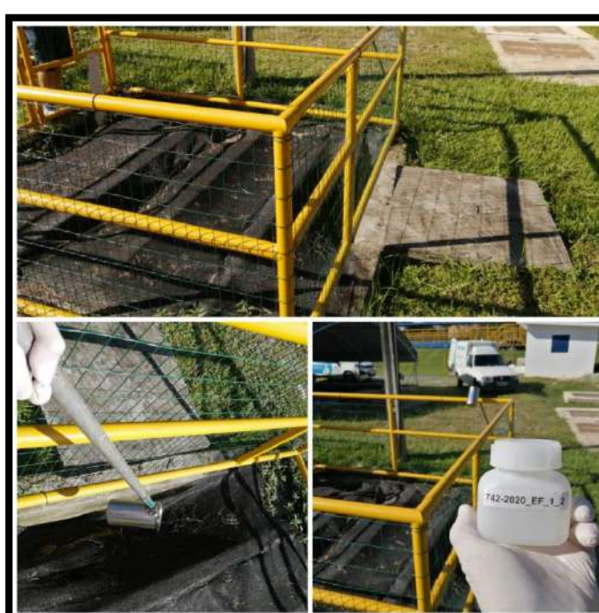
Saída ETE Profipo
