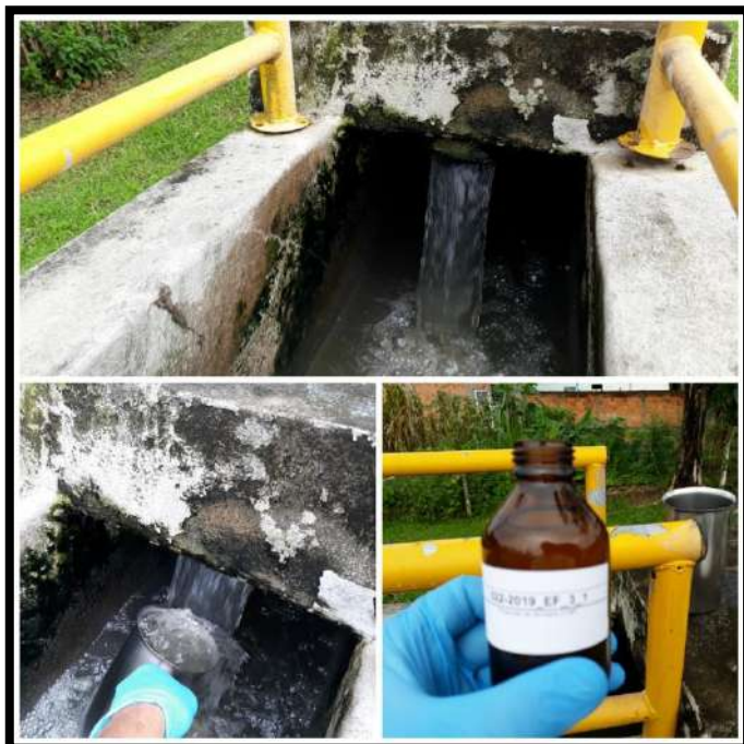
Entrada ETE Profipo
