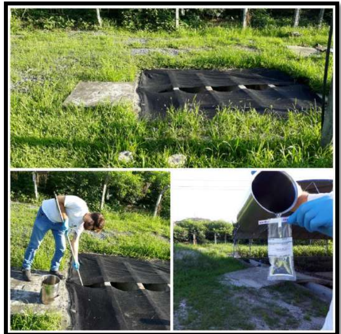
Saída ETE Profipo
