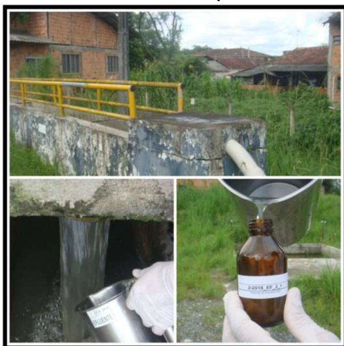
Entrada ETE Profipo
