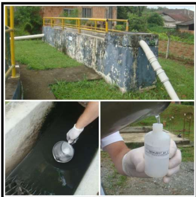
ETE Profipo Entrada
