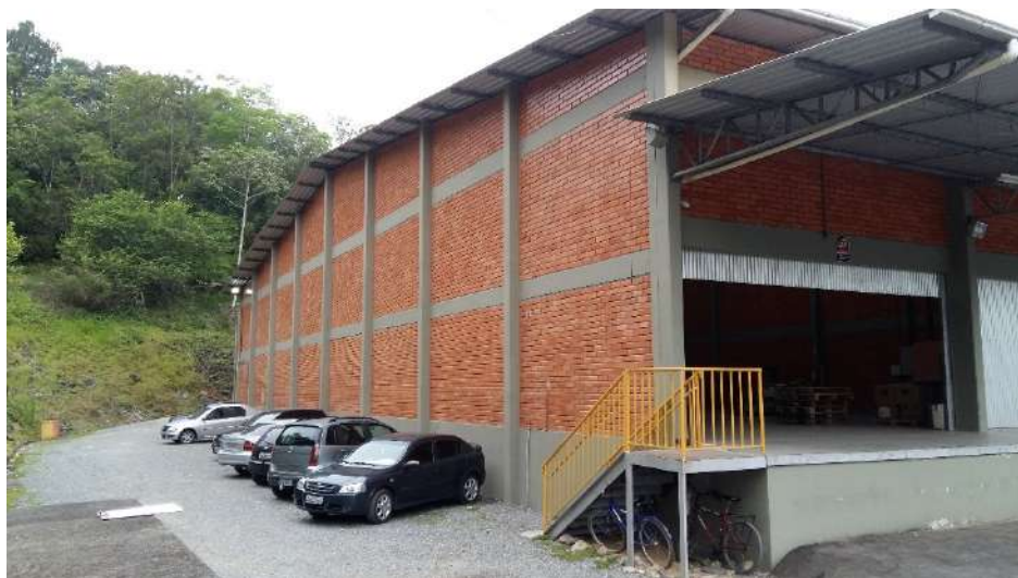
Figura 9: Fachada lateral, galpão 02 Fonte: Autor
