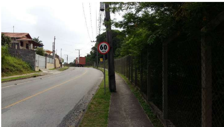
Figura 122: Calçada em frente ao imóvel, sentido BR-101 - rua Santa Catarina Fonte: Autor
