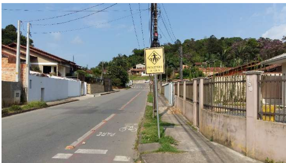
Figura 108: Sinalização viária - Placa indicativa para presença de faixa de pedestres e demarcação na via de ciclofaixa Fonte: Autor
