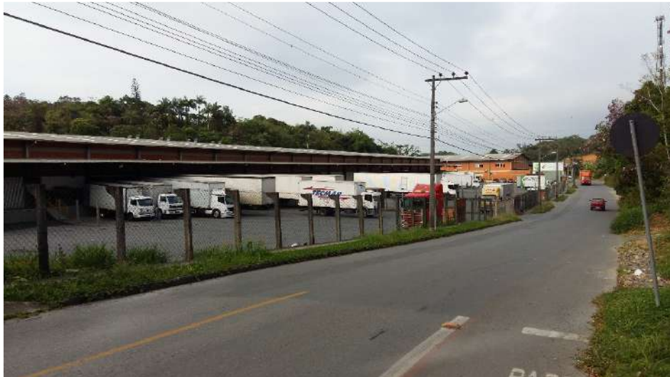
Figura 6: Fachada frontal, galpão 02 Fonte: Autor
