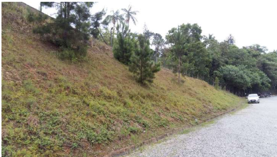
Figura 16– Taludes existentes no empreendimento Fonte: Autor
