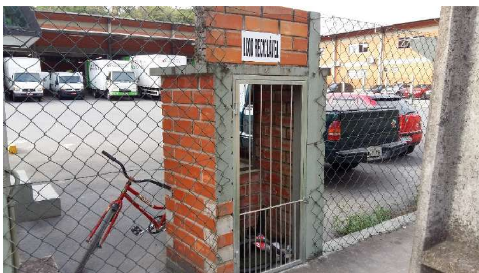
Figura 80: Baia para acondicionamento de lixo reciclável Fonte: Autor
