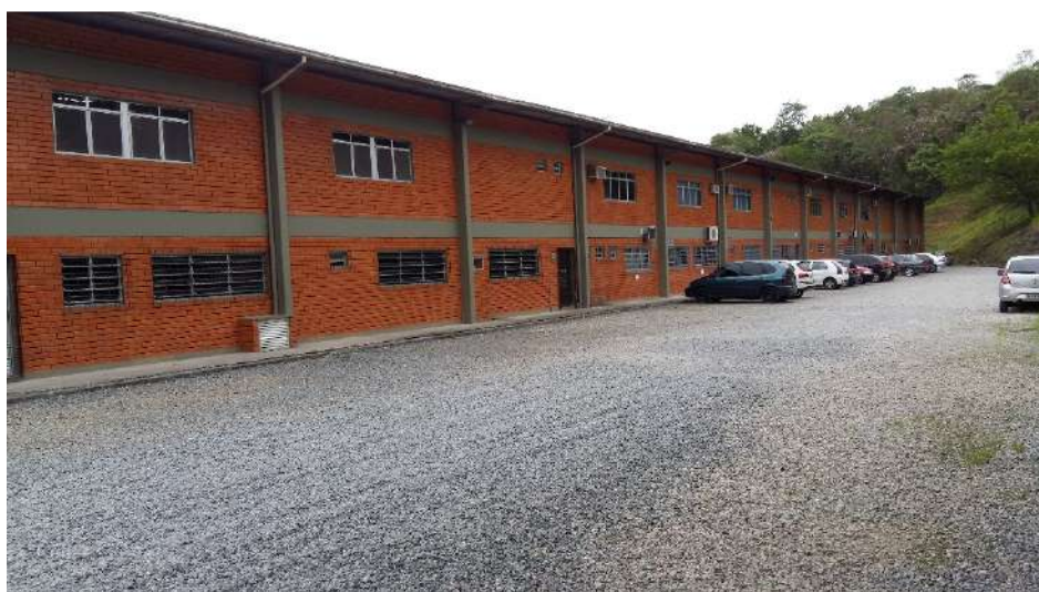
Figura 129: Estacionamento para carros, face posterior do imóvel, galpão 02 Fonte: Autor
