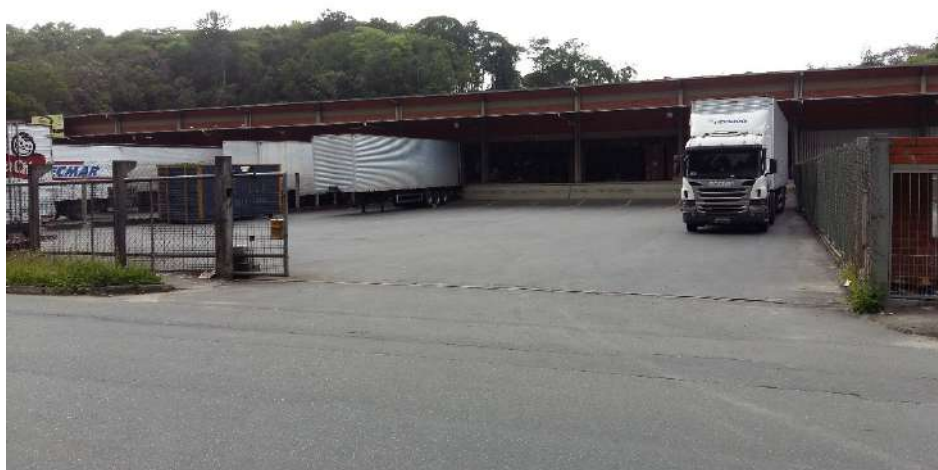
Figura 120: Acesso de caminhões para a unidade 03 do galpão 02 Fonte: Autor
