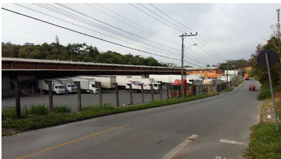
Figura 134: Docas e pátio de manobras, galpão 02 Fonte: Autor
