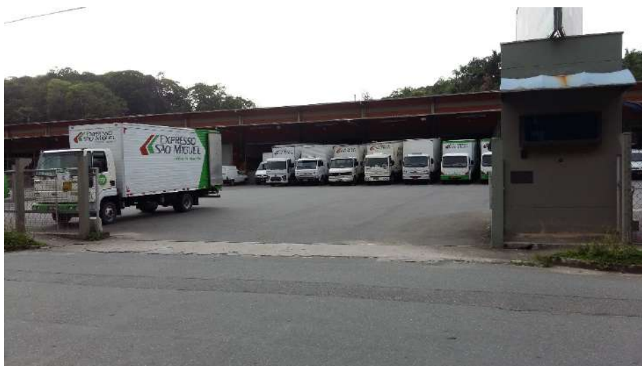
Figura 83: Pavimentação dos acessos e pátio de manobras do empreendimento Fonte: Autor
