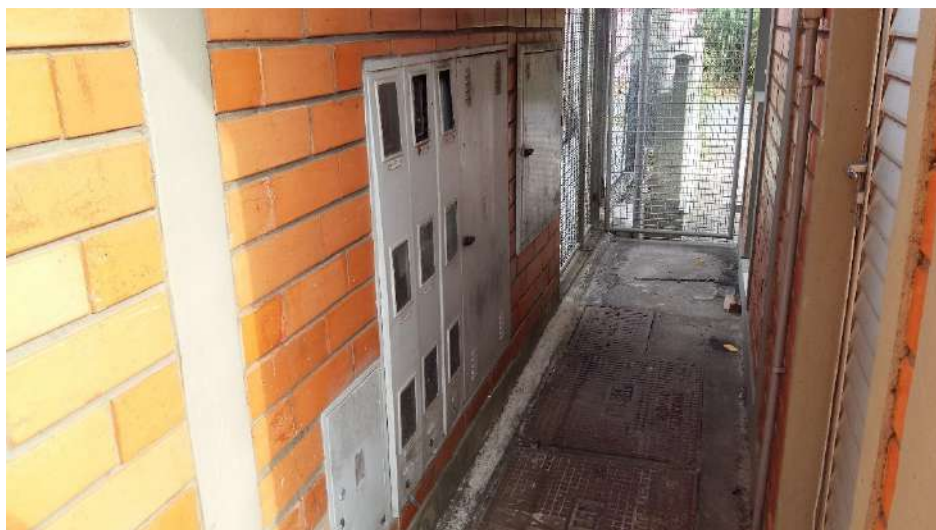
Figura 76: Padrão de entrada de energia do empreendimento Fonte: Autor
