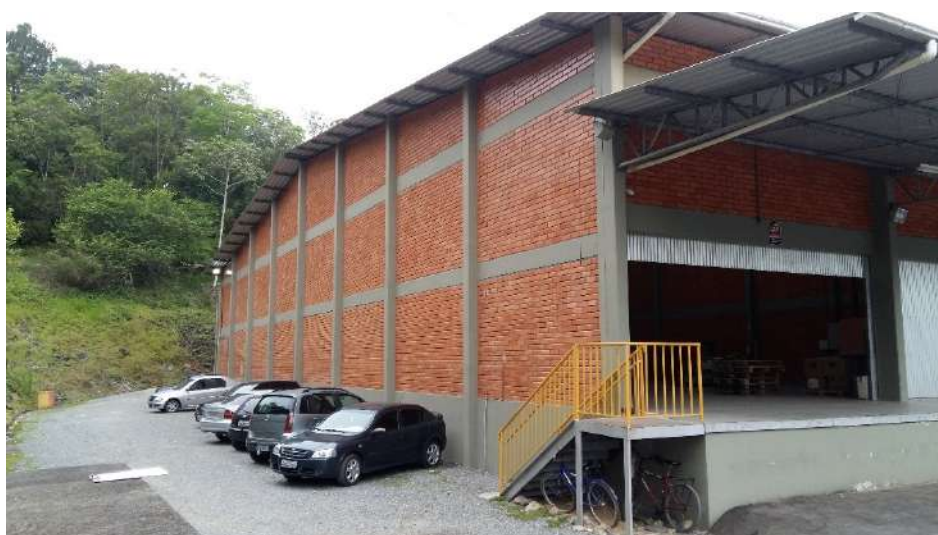
Figura 130: Estacionamento para carros, face lateral do imóvel, galpão 02 Fonte: Autor
