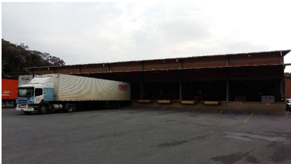
Figura 135: Docas e pátio de manobras, galpão 01 Fonte: Autor
