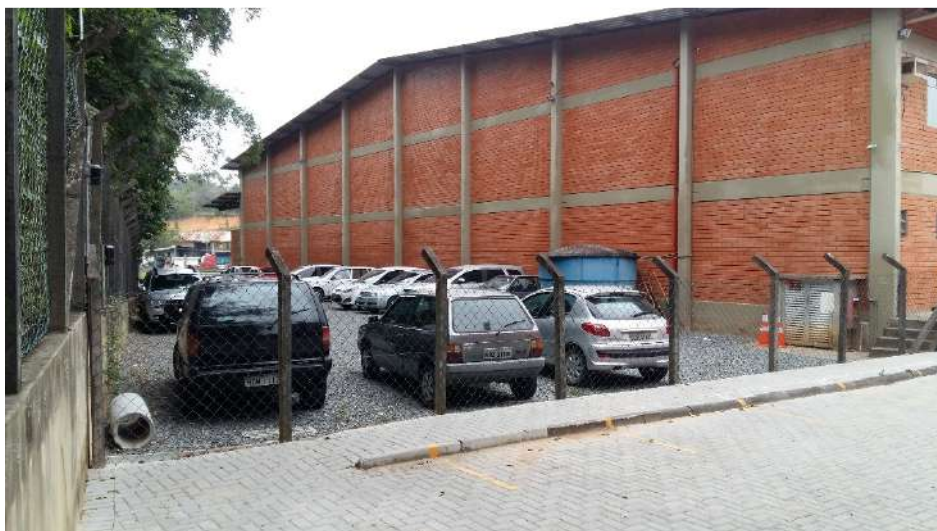
Figura 4: Fachada lateral, galpão 01 Fonte: Autor
