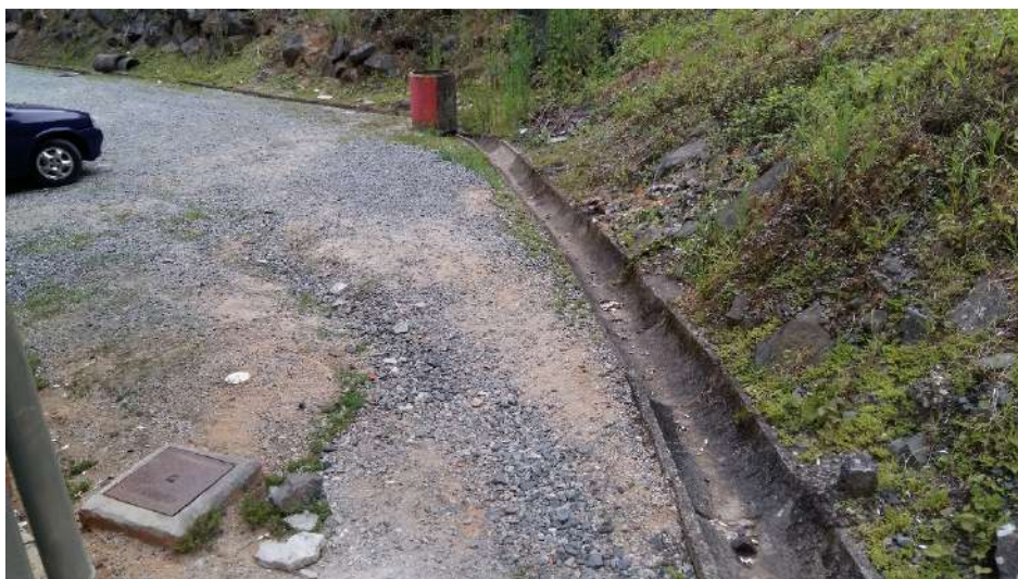
Figura 74: Ponto de inspeção do tanque do sistema de tratamento do esgoto, galpão 02 Fonte: Autor
