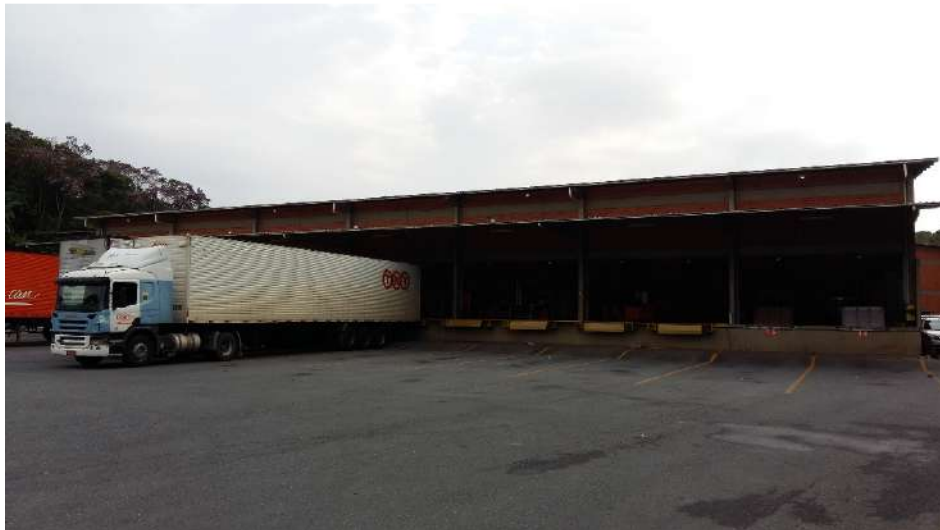
Figura 2: Fachada frontal, galpão 01 Fonte: Autor
