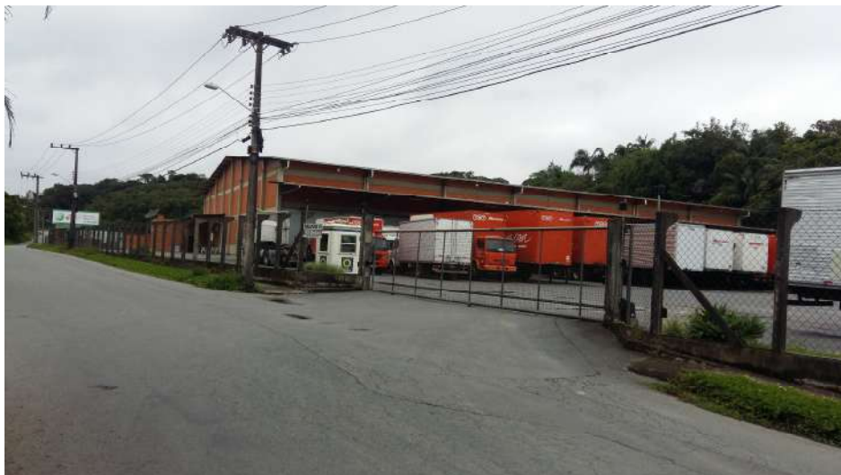
Figura 117: Acesso para o Galpão 01, motocicletas, automóveis e caminhões Fonte: Autor
