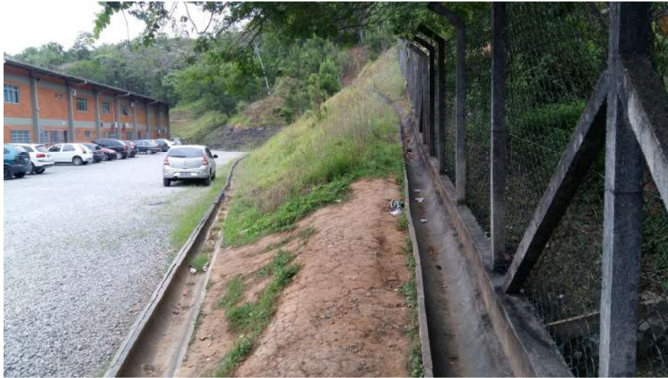
Figura 18 - Taludes e dispositivos de drenagem existentes Fonte: Autor
