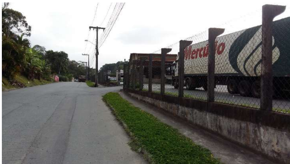
Figura 82: Pavimentação na rua Portugal Fonte: Autor
