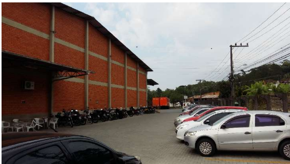
Figura 132: Estacionamento para carros, motos e bicicletário, face frontal do galpão 01 Fonte: Autor
