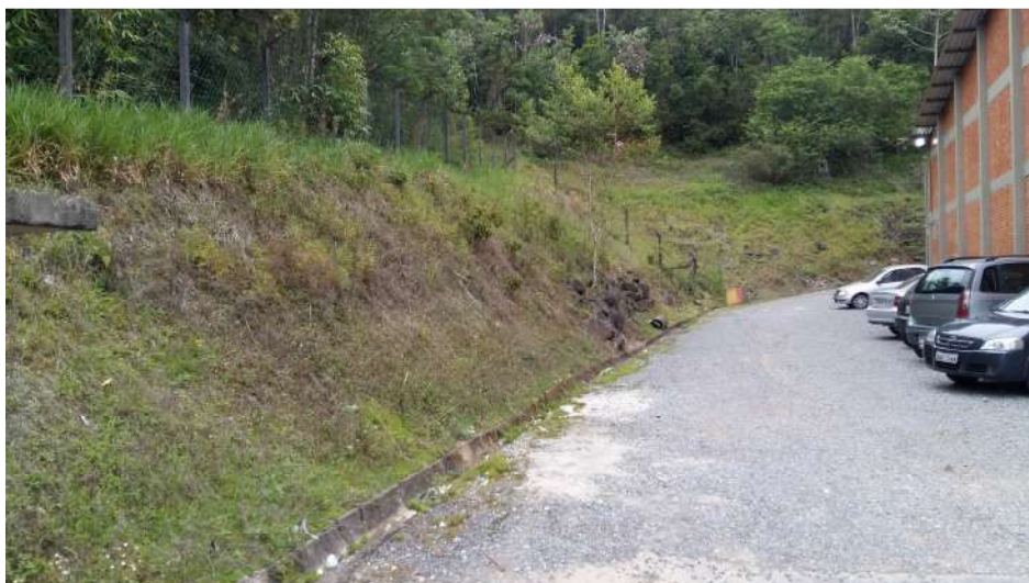
Figura 17 - Taludes existentes no empreendimento Fonte: Autor
