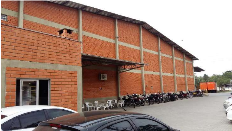
Figura 5: Fachada lateral, galpão 01 Fonte: Autor
