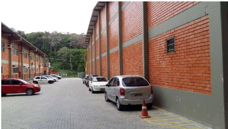
Figura 8: Fachada lateral, galpão 02 Fonte: Autor
