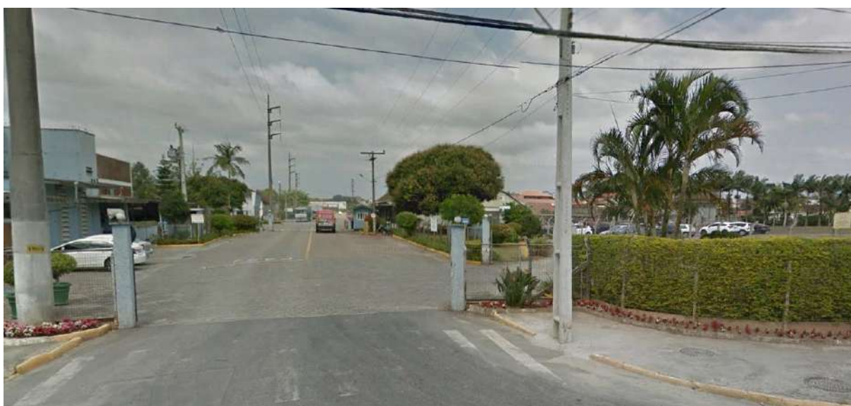
Figura 12: Vista de frente do empreendimento.
