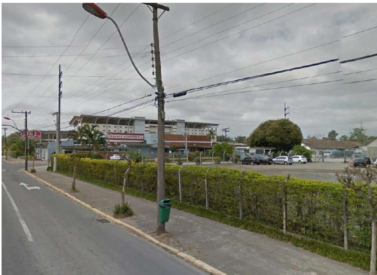
Figura 62: Rede elétrica passando pelo imóvel em estudo.
