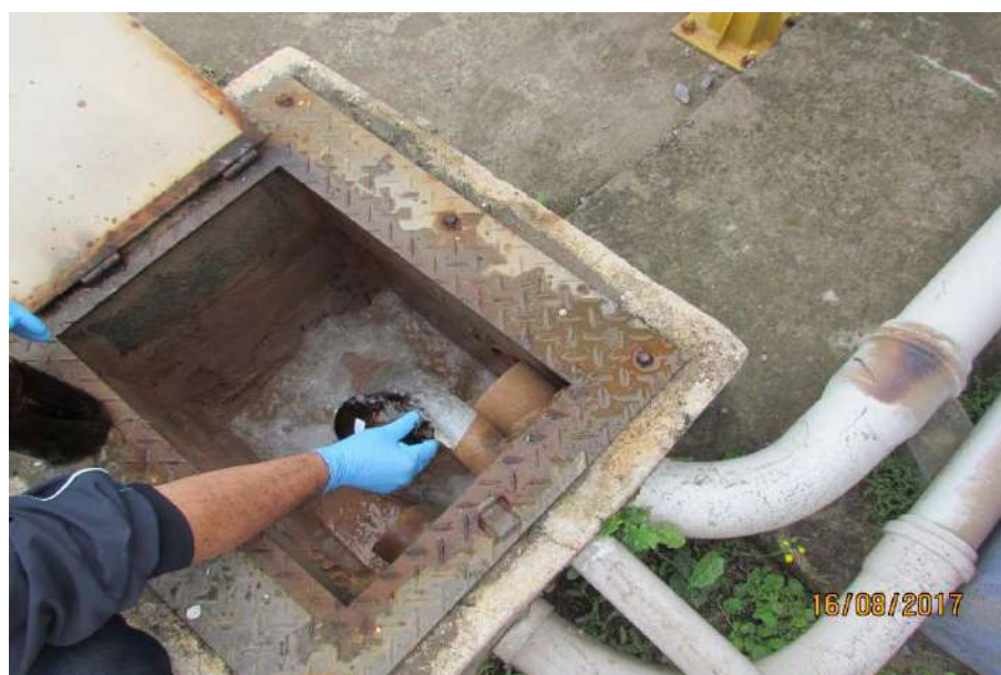
Figura 2 - Coleta no Ponto 01 – Saída da ETE do Morro do Amaral
