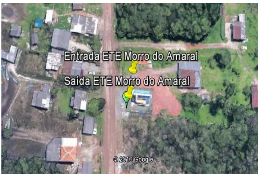
Figura 1 - Localização do ponto de amostragem da Saída da ETE do Morro do Amaral
