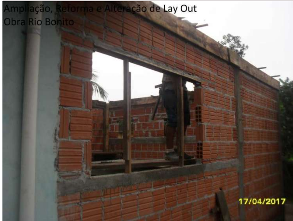
Ampliação, Reforma e Alteração de Lay Out Obra Rio Bonito
