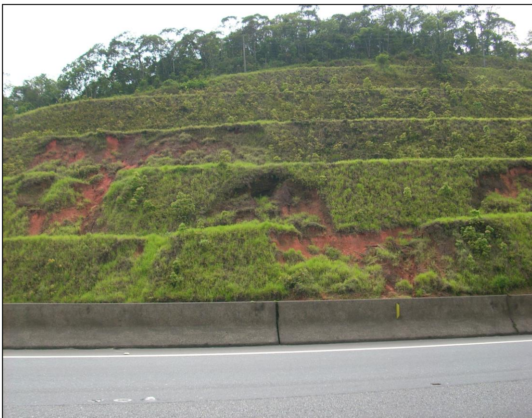
Figura 16. Quedas de taludes na BR 101, próximo a entrada para o distrito industrial de Joinville.
