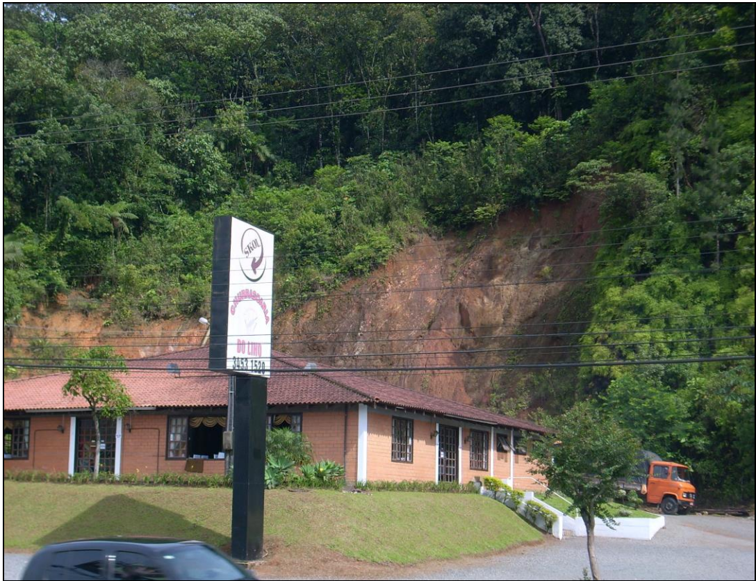
Figura 14. Exemplo de corte de barranco por ação antrópica, vulnerável a deslizamentos.
