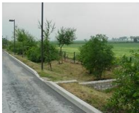
Foto 4.4 - Exemplo de valas de retenção com tabique
