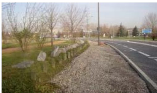
Foto 4.8 - Exemplo de trincheira de drenagem
