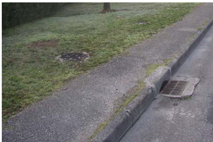
Foto 1.3 – Poço de Infiltração
