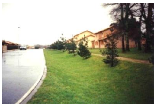
Figura 1.3 - Foto e croquis de uma vala de retenção
