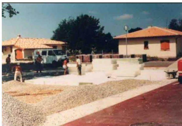
Foto 2.2 - Área Revestida com pedras permitindo a infiltração
