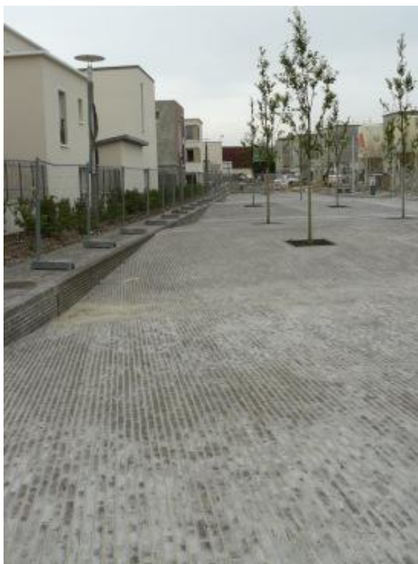
Foto 2.4 - Área pavimentada com blocos permitindo o armazenamento das águas pluviais
