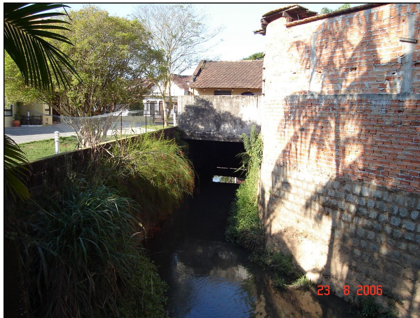
Figura 71 – Montante do ponto de estrangulamento na Rua Araquari.
