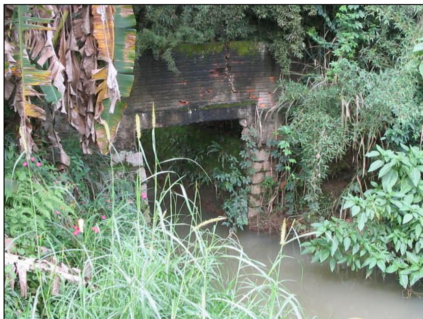
Figura 50 – Jusante do ponto de estrangulamento entre as Rua Luiz Delfino e Bento Gonçalves.
