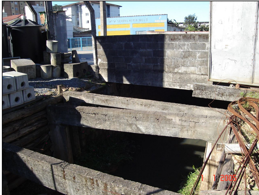
Figura 43 – Montante da ponte na Rua Luiz Delfino.
