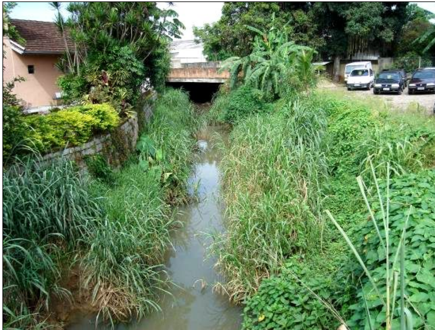
Figura 21 – Rio Morro Alto visto da Rua Dr. João Colin à montante.
