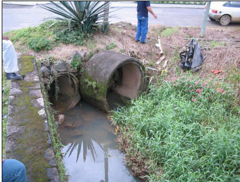
Figura 37 – Montante do ponto de estrangulamento da seção na travessia da Rua XV de Novembro.
