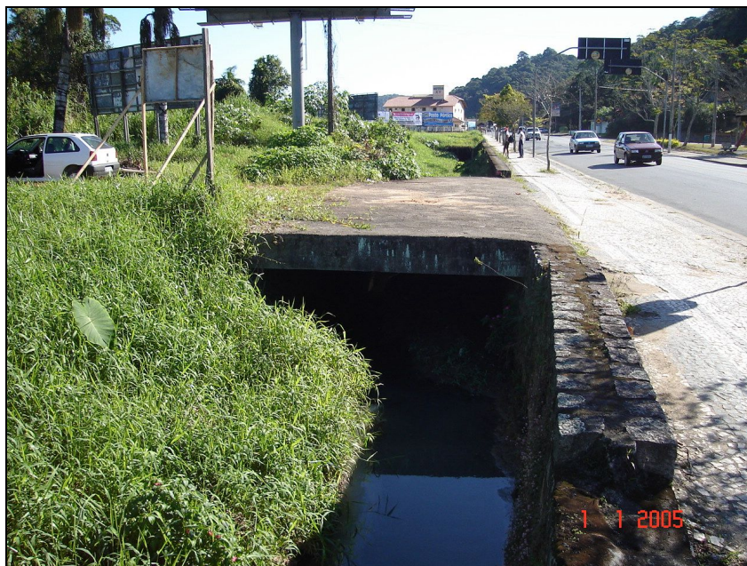
Figura 36 – Jusante do ponto de estrangulamento da seção na lateral da Rua XV de Novembro.
