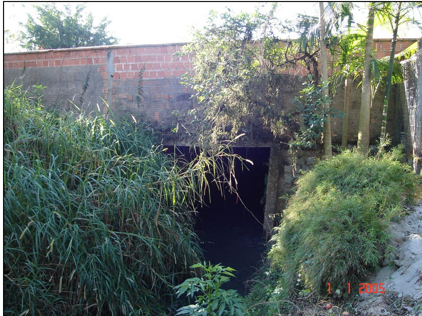
Figura 51 – Montante da seção entre às Ruas Bento Gonçalves e Marquês de Olinda.
