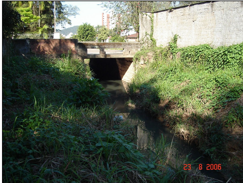
Figura 65 – Montante do ponto de estrangulamento na Rua Orleans.
