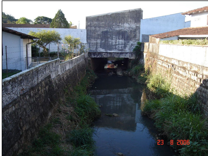
Figura 81 – Montante do ponto de estrangulamento entre as Ruas Frederico Hubner e Blumenau.
