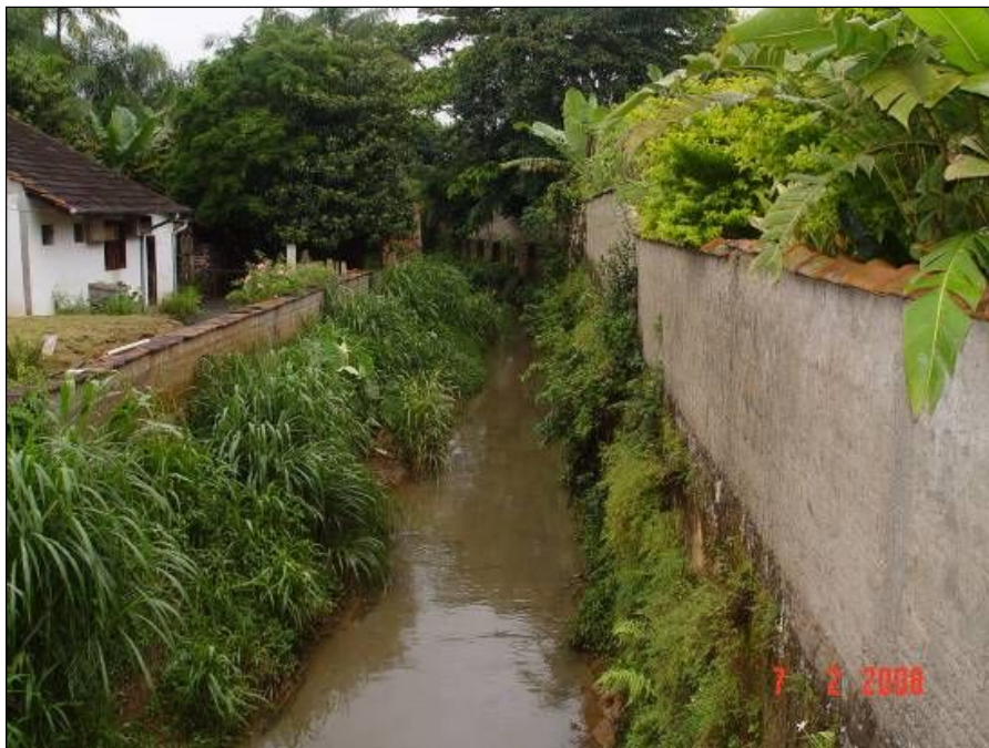
Figura 11 – Final do trecho 4, com o Rio Morro Alto canalizado.
