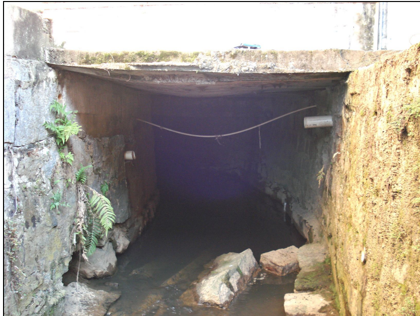
Figura 39 – Montante do ponto de estrangulamento nos fundos da Panificadora Blupão.
