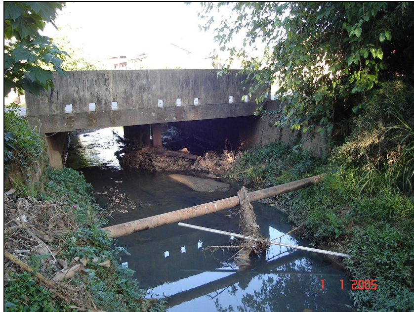
Figura 61 – Montante do ponto de estrangulamento na Rua Criciúma.
