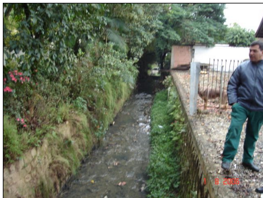
Figura 54 – Jusante da seção na Rua Marquês de Olinda.
