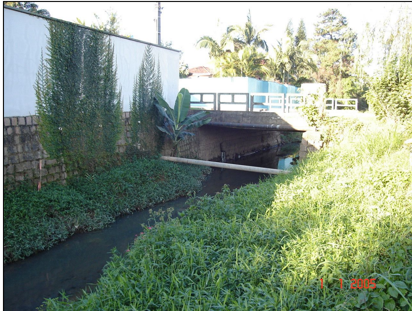
Figura 63 – Montante do ponto de estrangulamento na Rua Dos Atletas.
