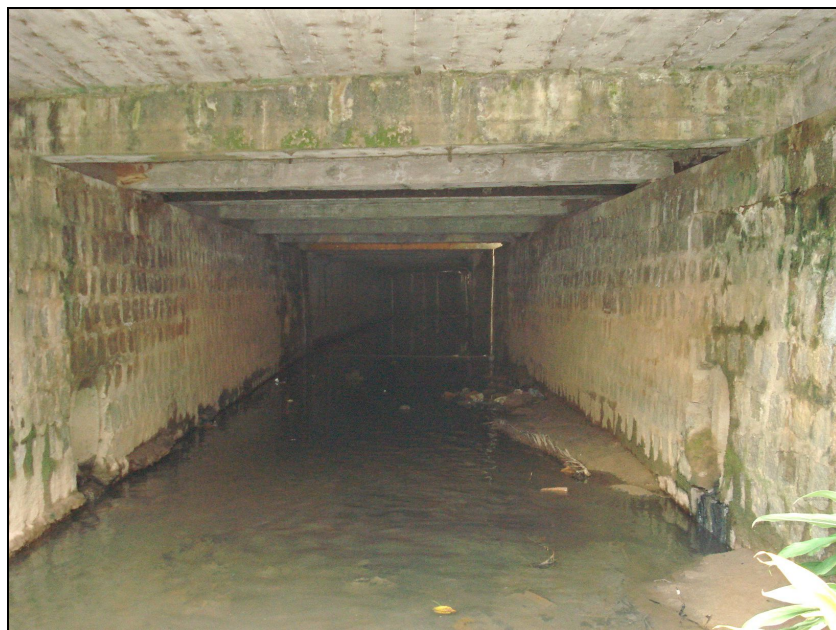
Figura 46 – Jusante da galeria na Rua Luiz Delfino.
