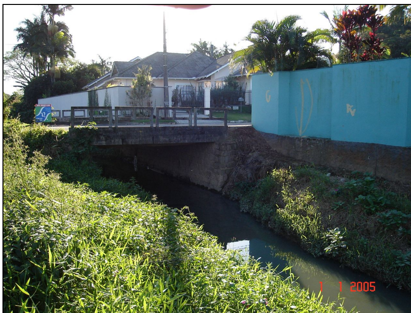
Figura 64 – Jusante do ponto de estrangulamento na Rua Dos Atletas.
