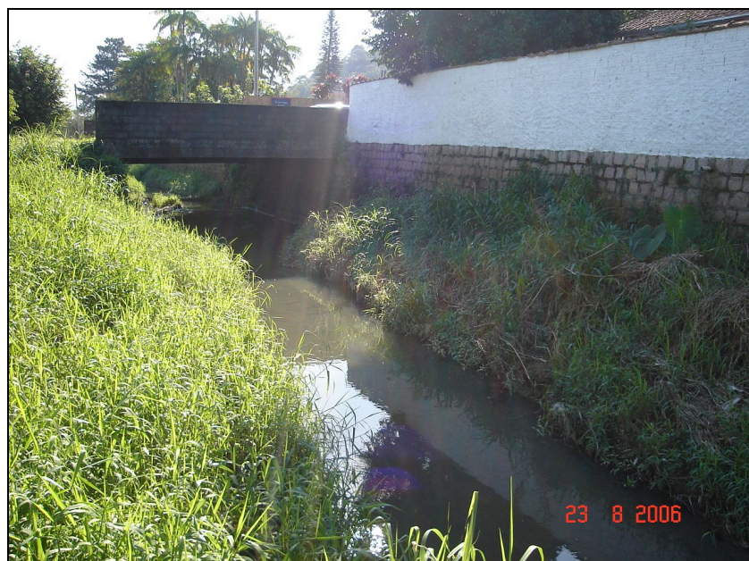
Figura 68 – Jusante da seção da Rua Presidente Castelo Branco.
