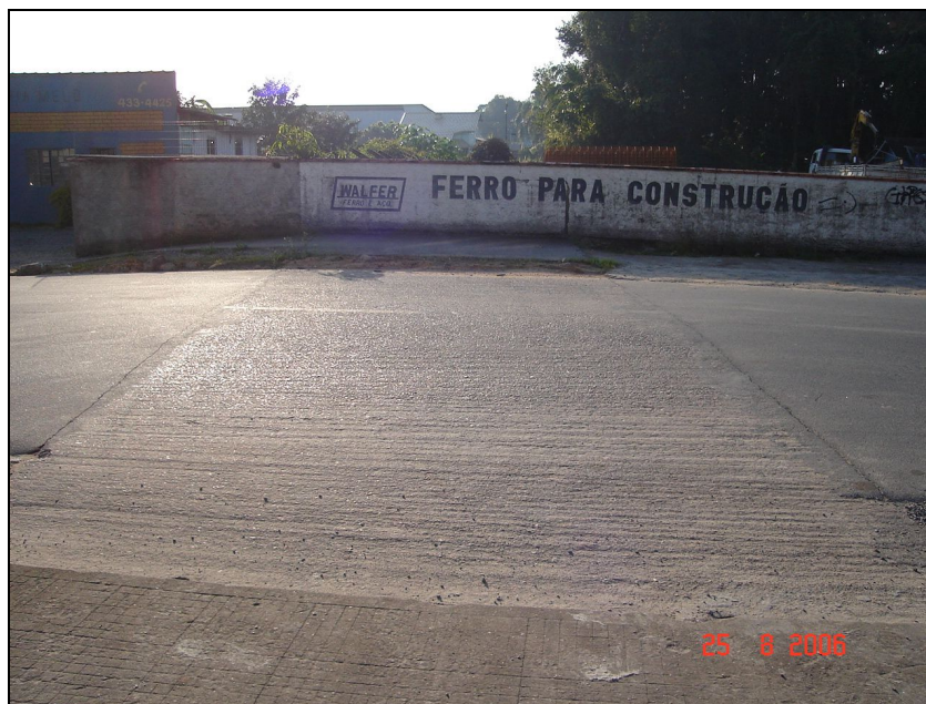
Figura 44 – Jusante da ponte na Rua Luiz Delfino.
