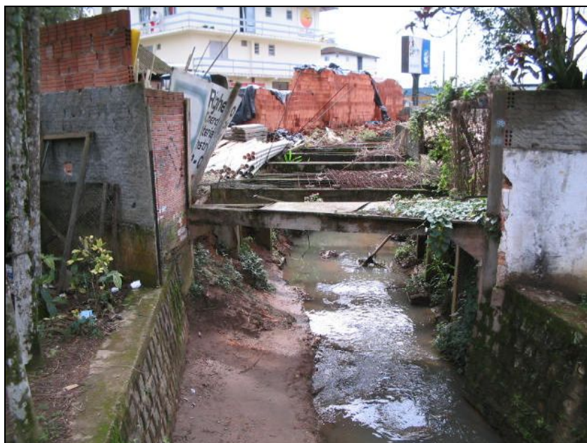
Figura 42 – Jusante da seção estrangulada na Rua Baggestonss.
