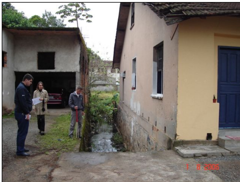
Figura 40 – Jusante do Ponto de estrangulamento nos fundos da Panificadora Blupão.
