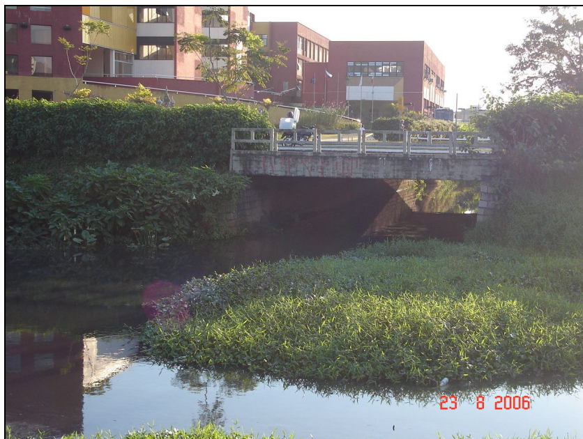
Figura 92 – Jusante da seção na Avenida José Vieira, foz do Rio Morro Alto no Rio Cachoeira.
