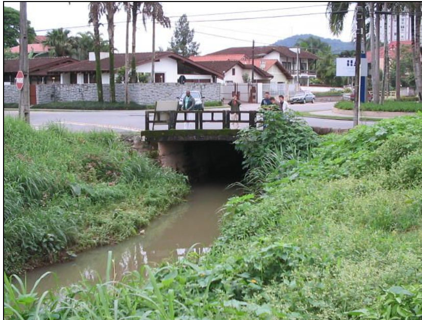
Figura 77 – Montante do ponto de estrangulamento no cruzamento das Ruas Timbó e Conselheiro Arp.
