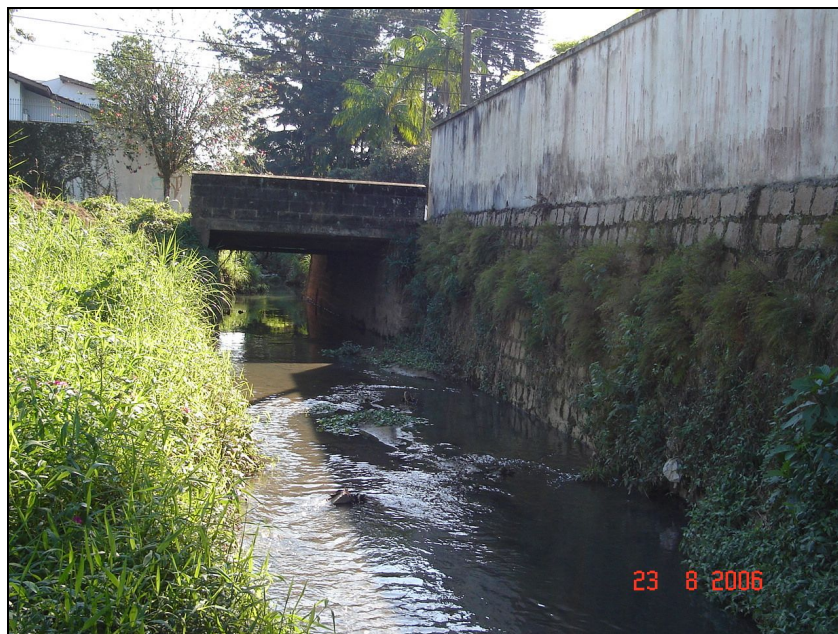
Figura 66 – Jusante do ponto de estrangulamento na Rua Orleans.
