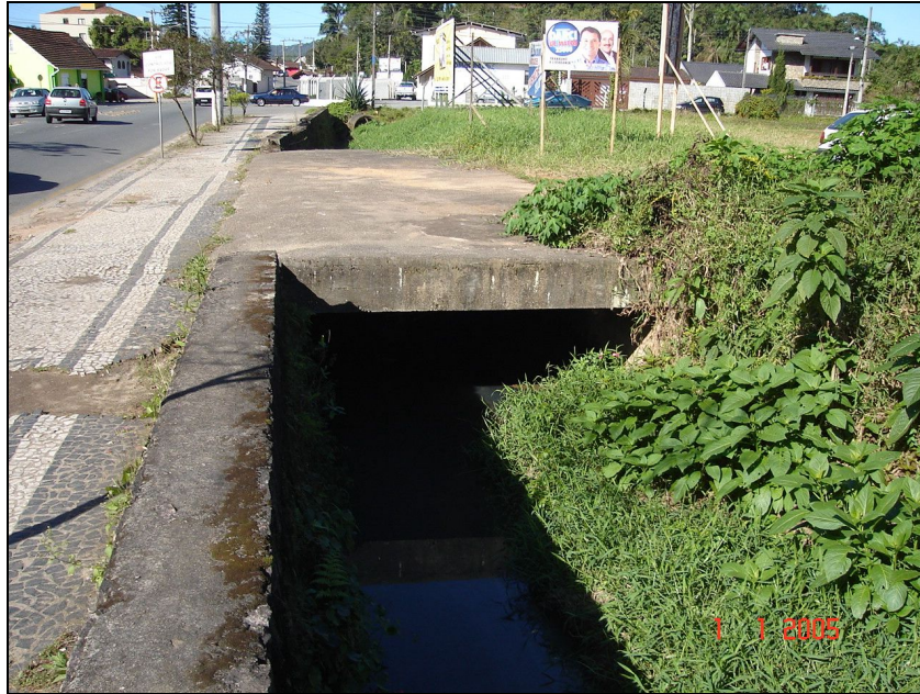
Figura 35 – Montante do ponto de estrangulamento da seção na lateral da Rua XV de Novembro.
