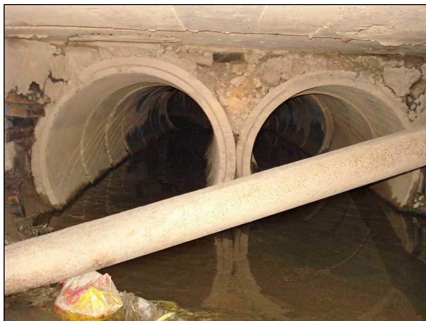
Figura 38 – Seção estrangulada sob edificações à jusante.
