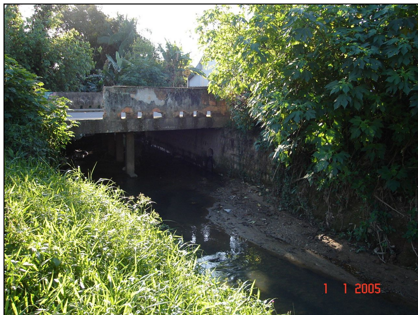
Figura 62 – Jusante do ponto de estrangulamento na Rua Criciúma.
