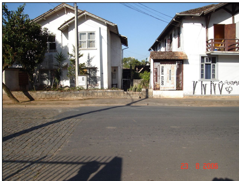
Figura 76 – Jusante do ponto de estrangulamento na Rua Jaraguá.
