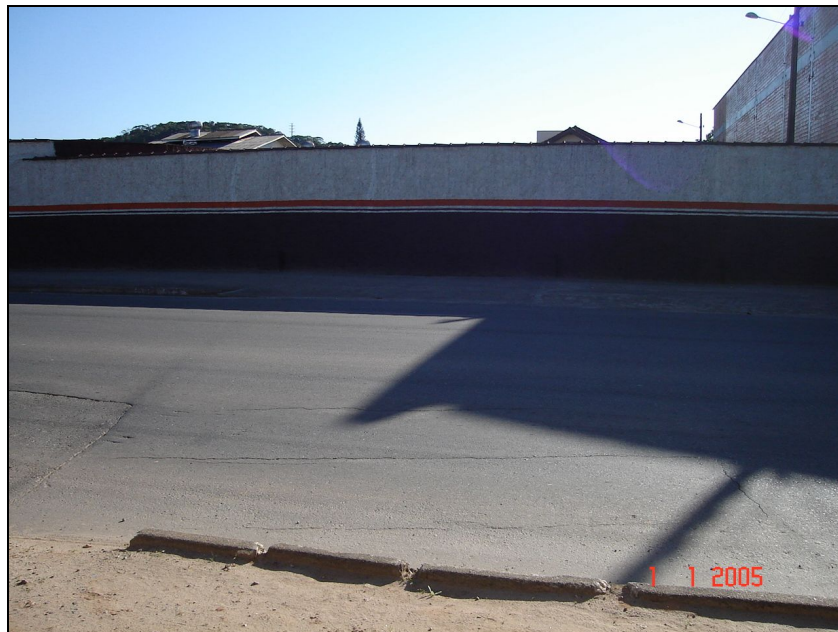
Figura 53 – Montante da seção na Rua Marquês de Olinda.
