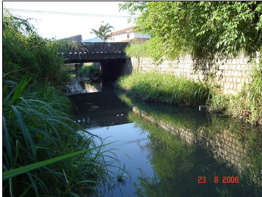
Figura 79 – Montante da seção na Rua Frederico Hubner.
