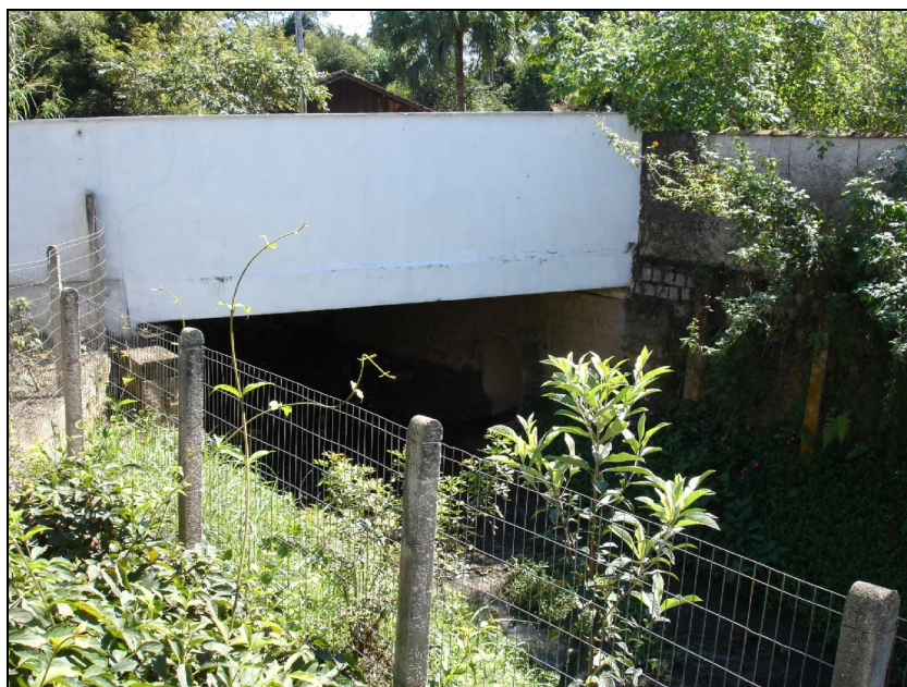
Figura 56 – Jusante da seção da Rua Karl Kumlehn.
