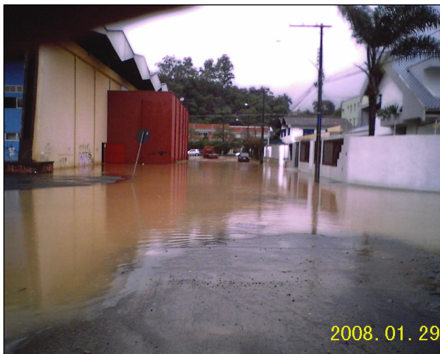
Figura 27 – Inundação na Rua Dos Atletas esquina com a Rua Timbó.
