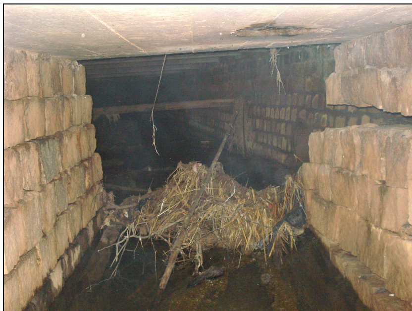
Figura 52 – Montante na galeria entre às Ruas Bento Gonçalves e Marquês de Olinda.
