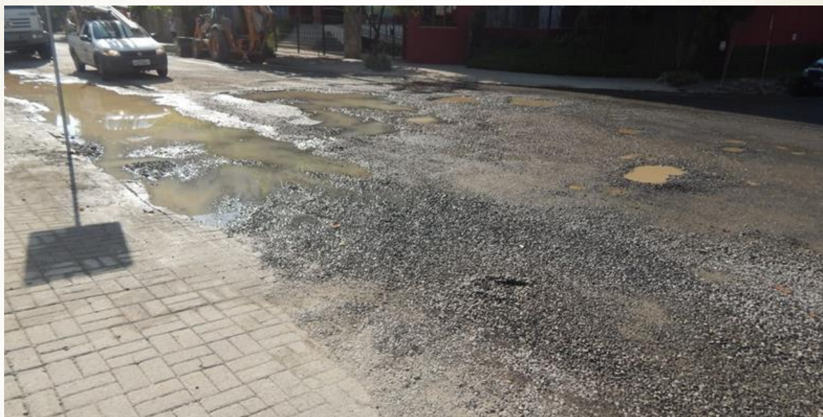
Figura 43 - Obras de macrodrenagem do Rio Mathias – 23.02.2017 - Rua Otto Boehm.
