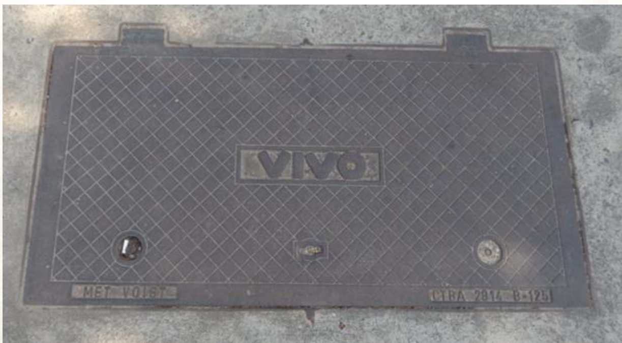
Figura 42 - Caixa de entrada da rede de telefonia próxima ao imóvel.
