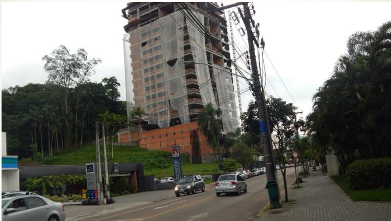
Figura 46 - Poste de iluminação pública da Rua Otto Boehm
