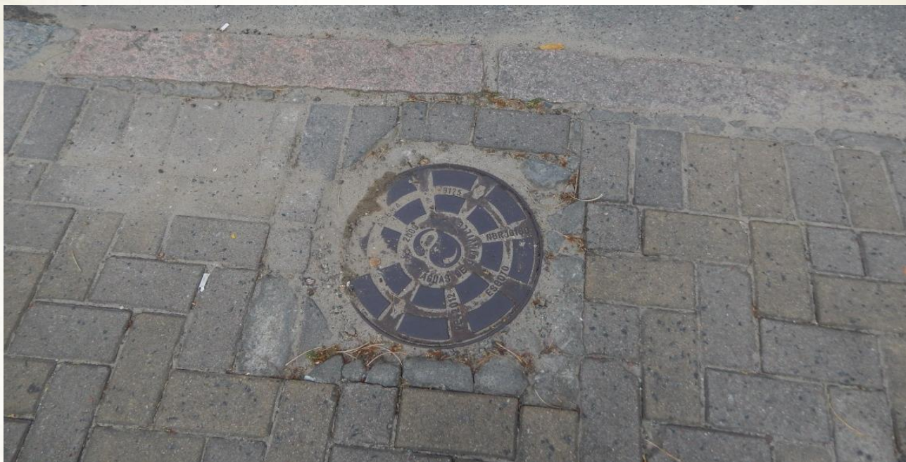
Figura 40 - Tampa de inspeção de esgoto sanitário na Rua Otto Boehm.
