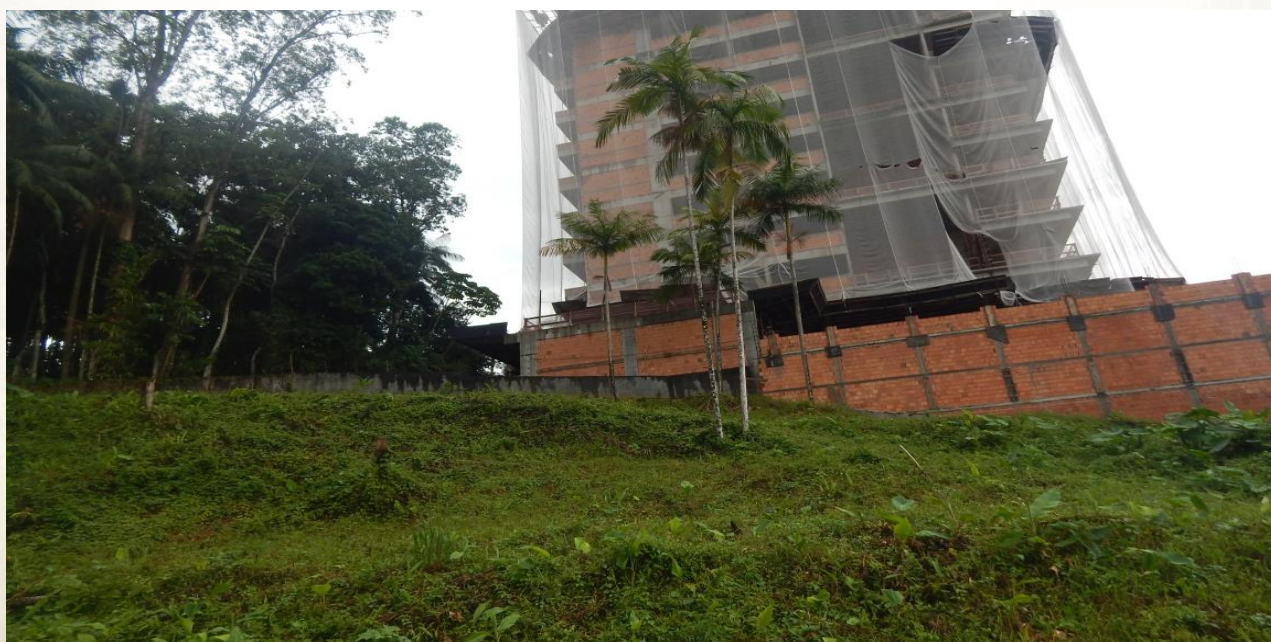
Figura 2 - Imagem do terreno do imóvel
