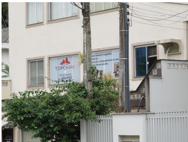
Figura 15 - P7: Serviço de topografia.
