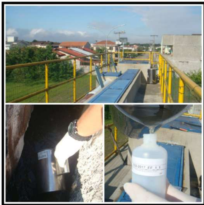
Entrada ETE Espinheiros
