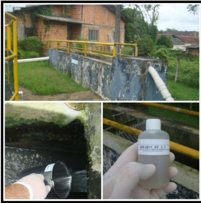
Entrada ETE Profipo
