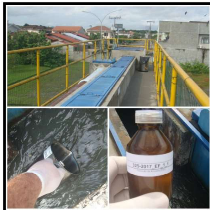
Entrada ETE Espinheiros
