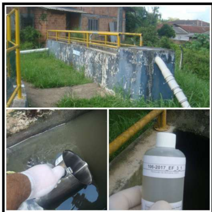
Entrada ETE Profipo
