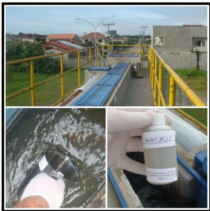
Entrada ETE Espinheiros
