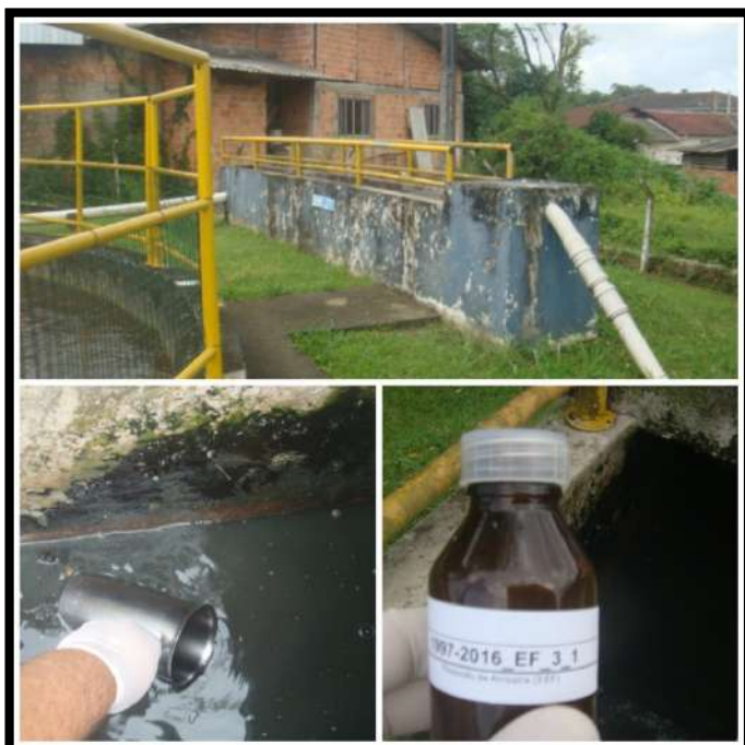
ETE Profipo Entrada
