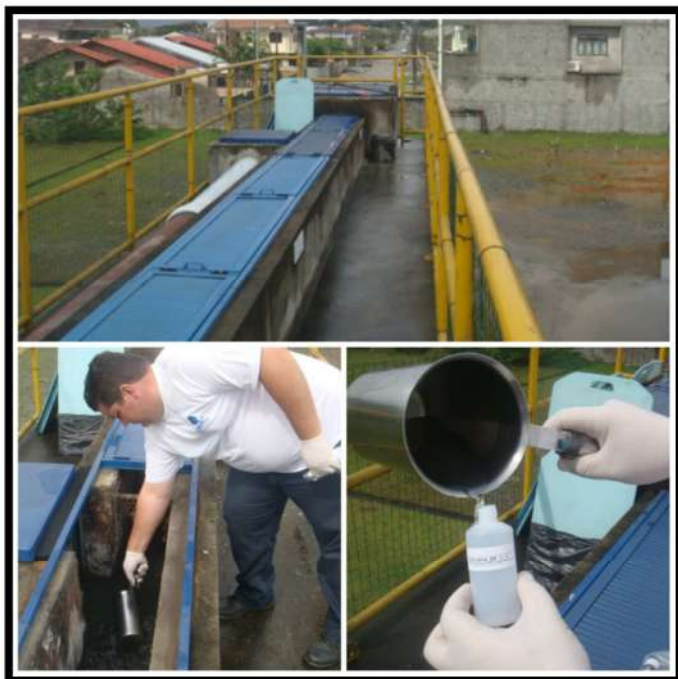
Entrada ETE Espinheiros
