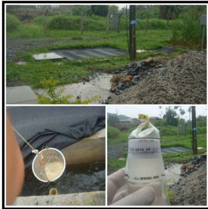
Saída ETE Profipo
