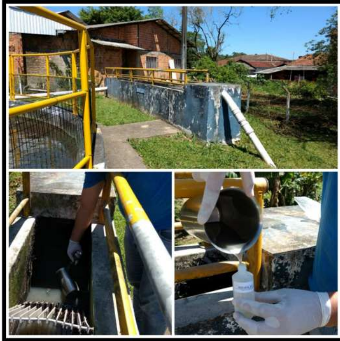
ETE Profipo Entrada
