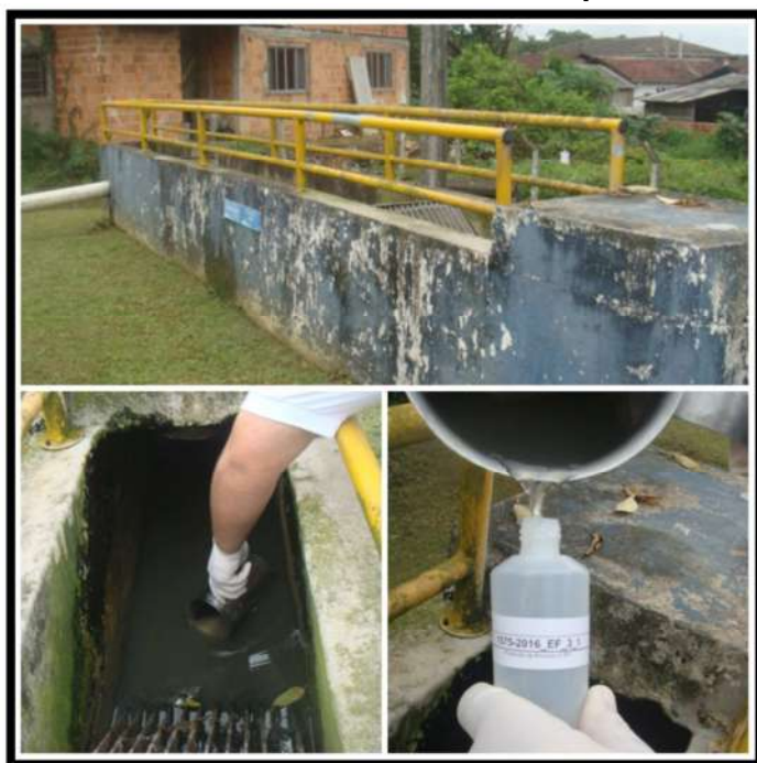
Entrada ETE Profipo
