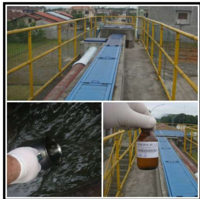
Entrada ETE Espinheiros
