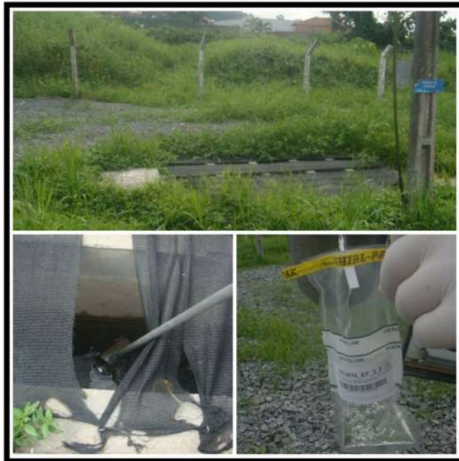
Saída ETE Profipo
