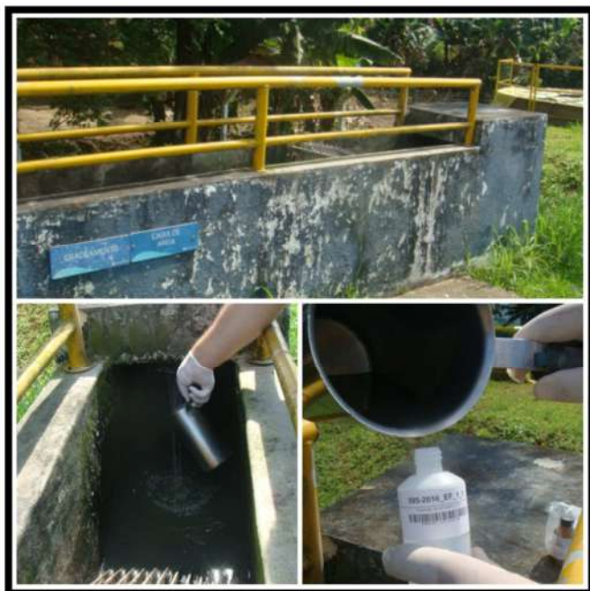
ETE Profipo Entrada
