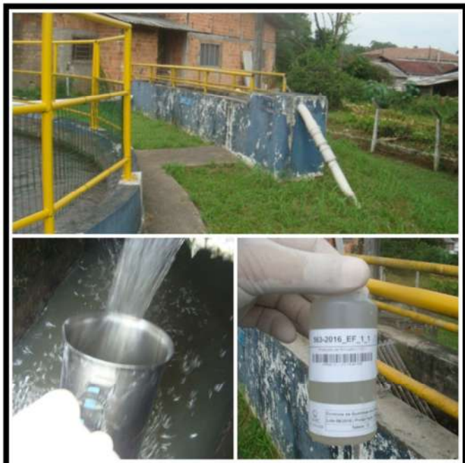
Entrada ETE Profipo
