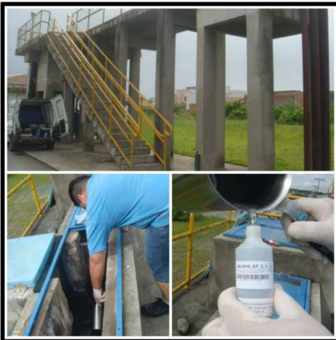
Entrada ETE Espinheiros
