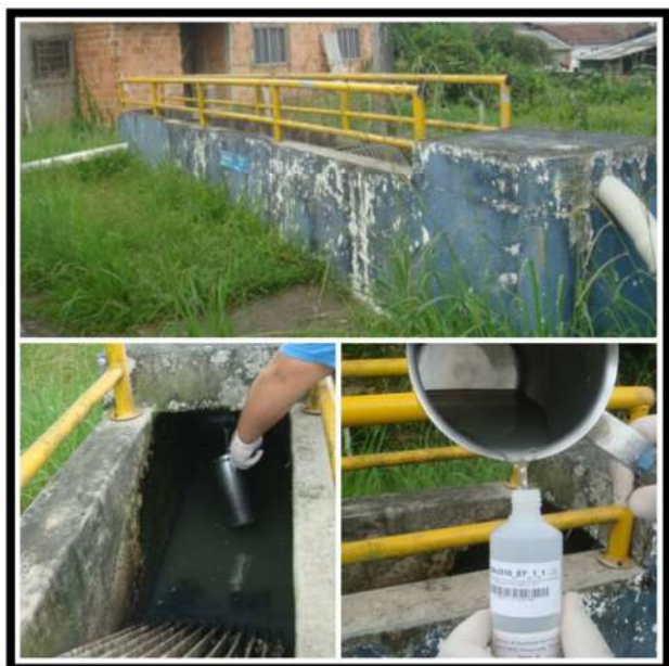
Entrada ETE Profipo
