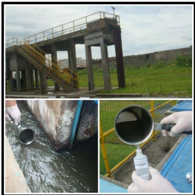
Entrada ETE Espinheiros
